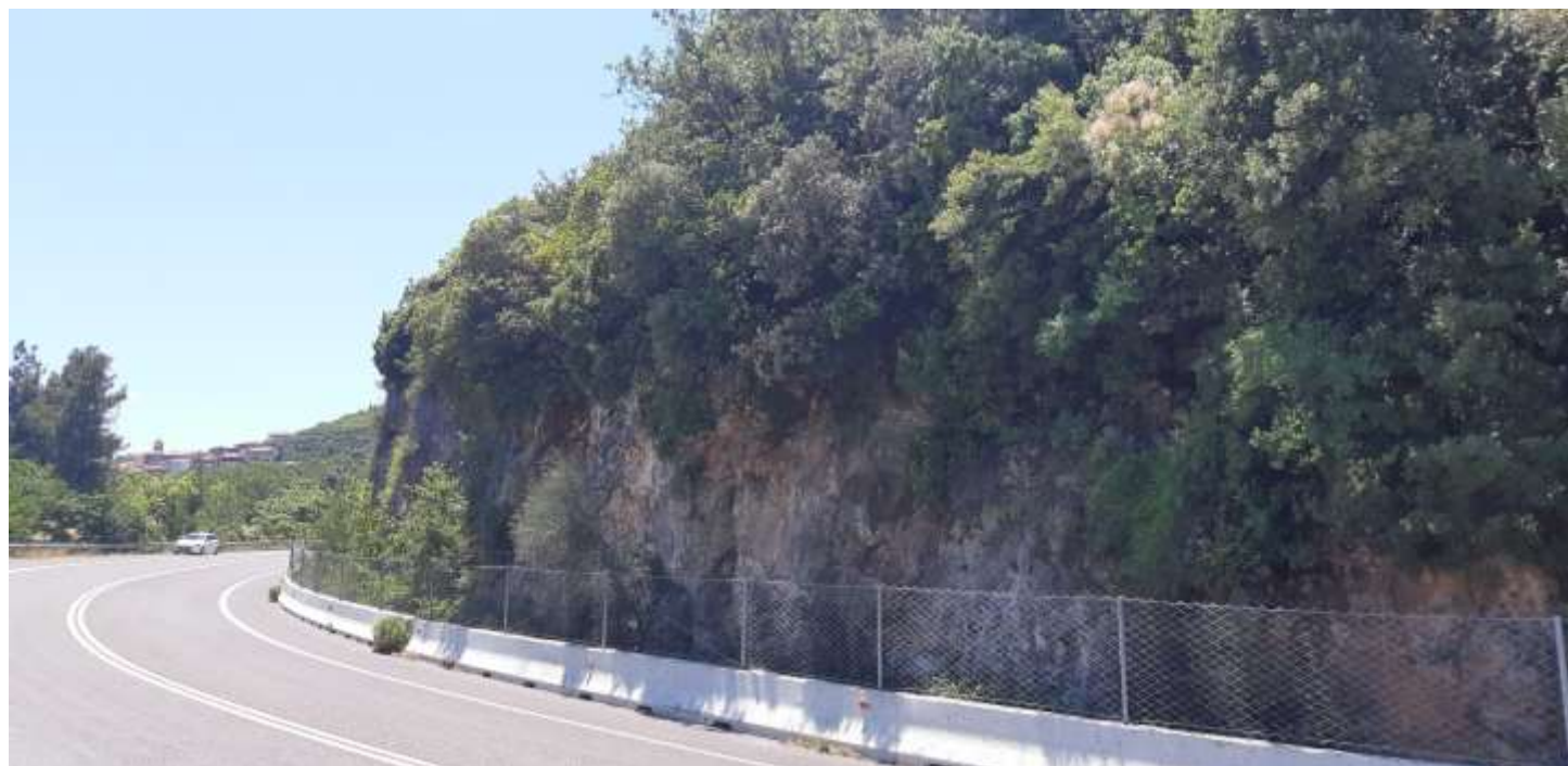
Φωτ. 4.2 : Τμήμα 4 – Μετά τις εργασίες προστασίας (Ιούνιος 2021)
