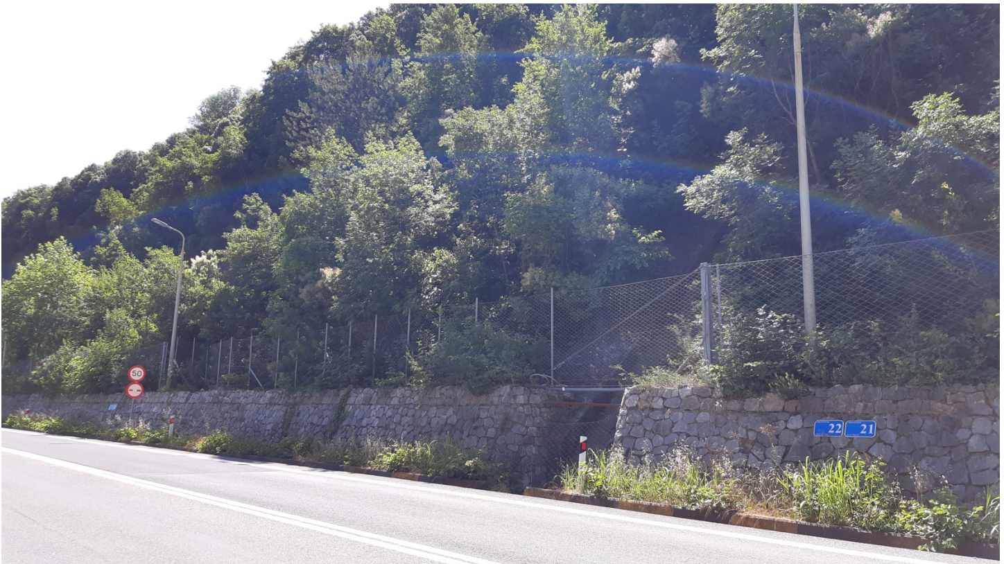
Φωτ. 22.2 : Τμήμα 22 – Μετά τις εργασίες προστασίας (Ιούνιος 2020)
