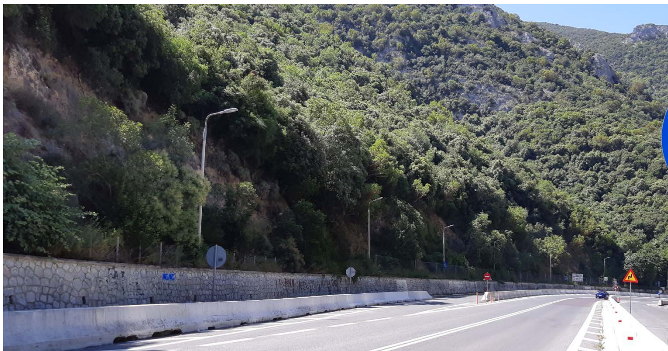
Φωτ. 16.2 : Τμήμα 16 – Μετά τις εργασίες προστασίας (Ιούνιος 2020)
