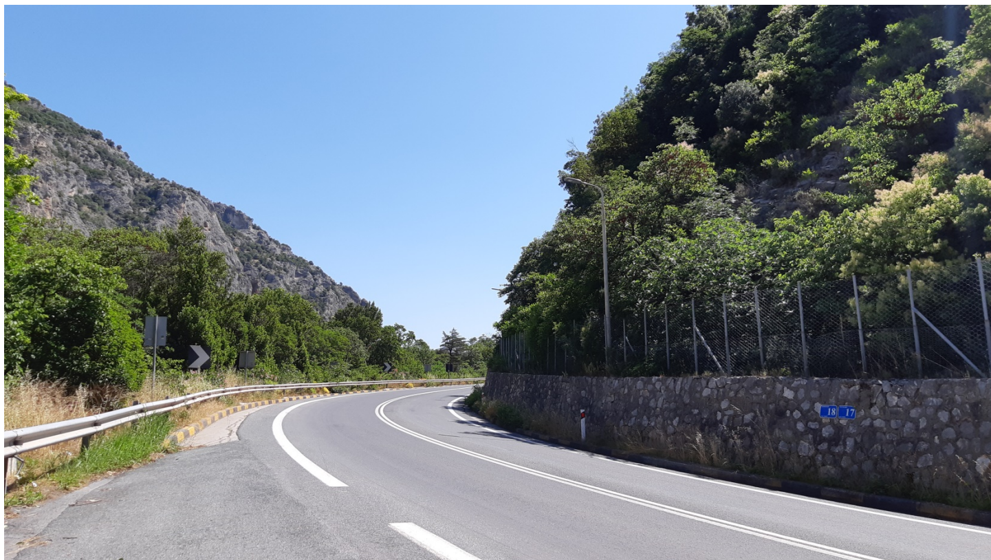
ΦΩΤ. 18.2 : Τμήμα 18 – Μετά τις εργασίες προστασίας (Ιούνιος 2020)
