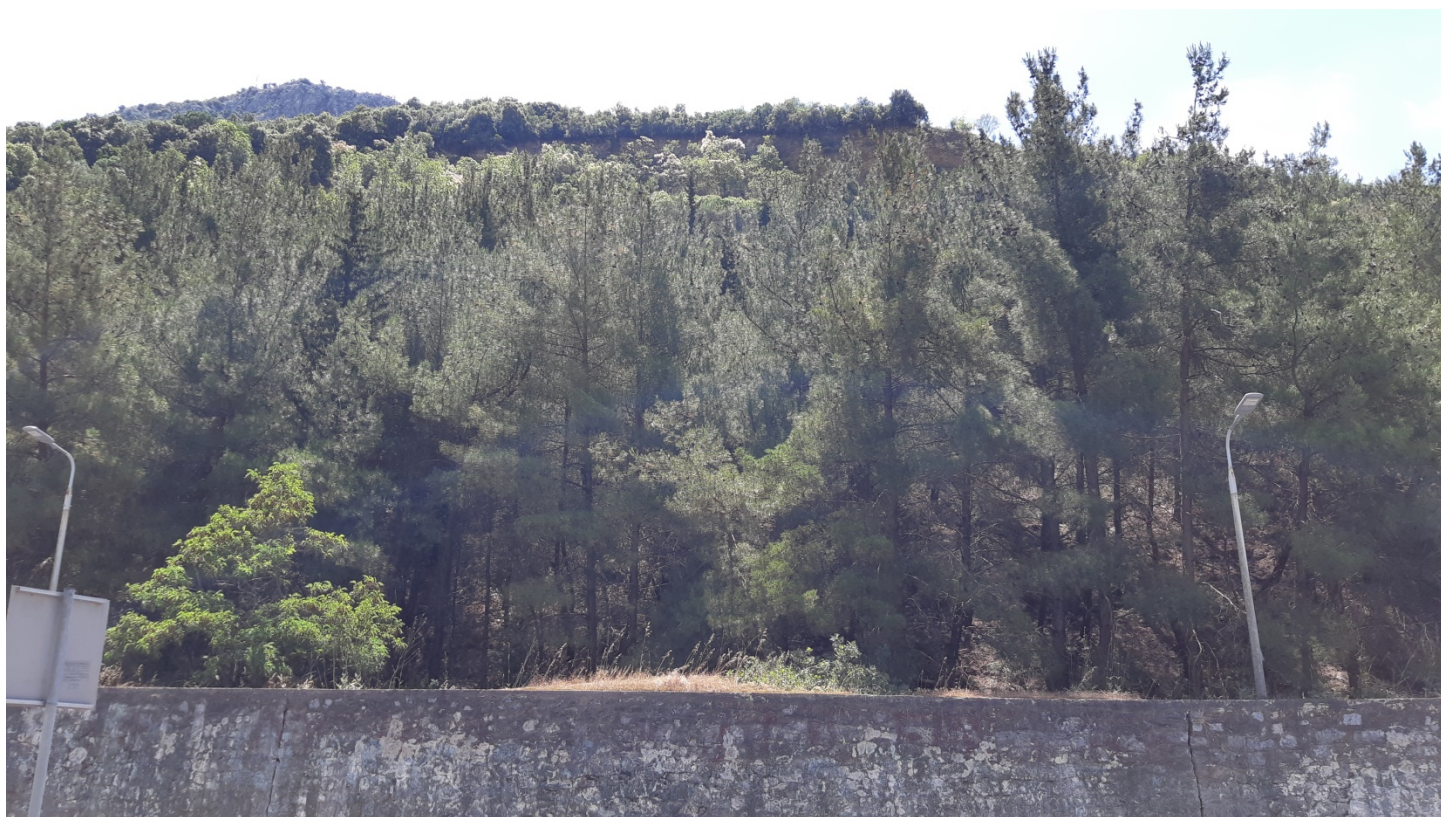
Φωτ. 2.2: Τμήμα 2 – Μετά τις εργασίες προστασίας (Ιούνιος 2020)
