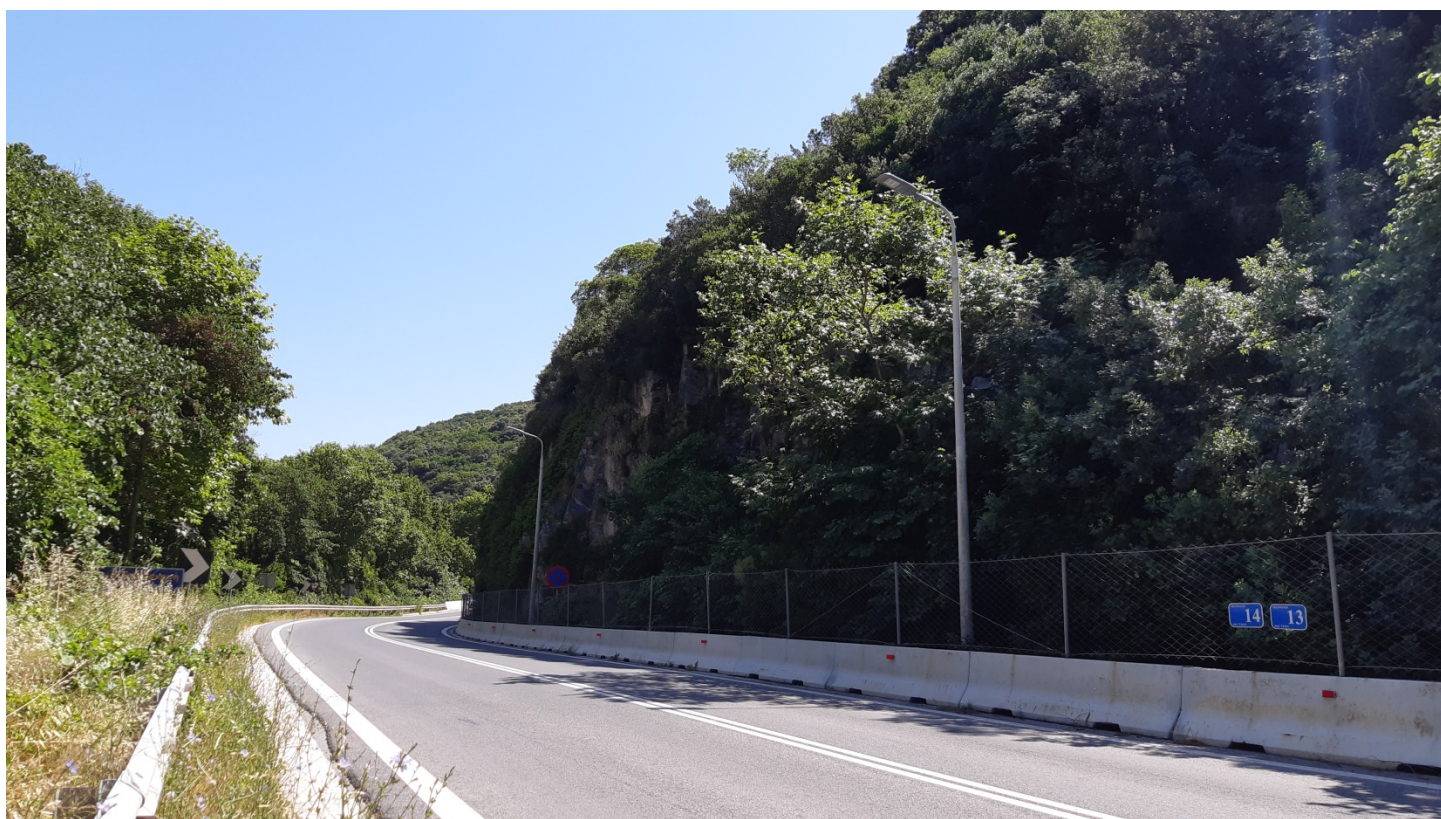
Φωτ. 14.2 : Τμήμα 14 – Μετά τις εργασίες προστασίας (Ιούνιος 2020)
