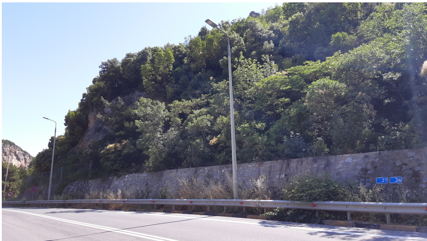
Φωτ. 27.2 : Τμήμα 27 – Μετά τις εργασίες προστασίας (Ιούνιος 2020)
