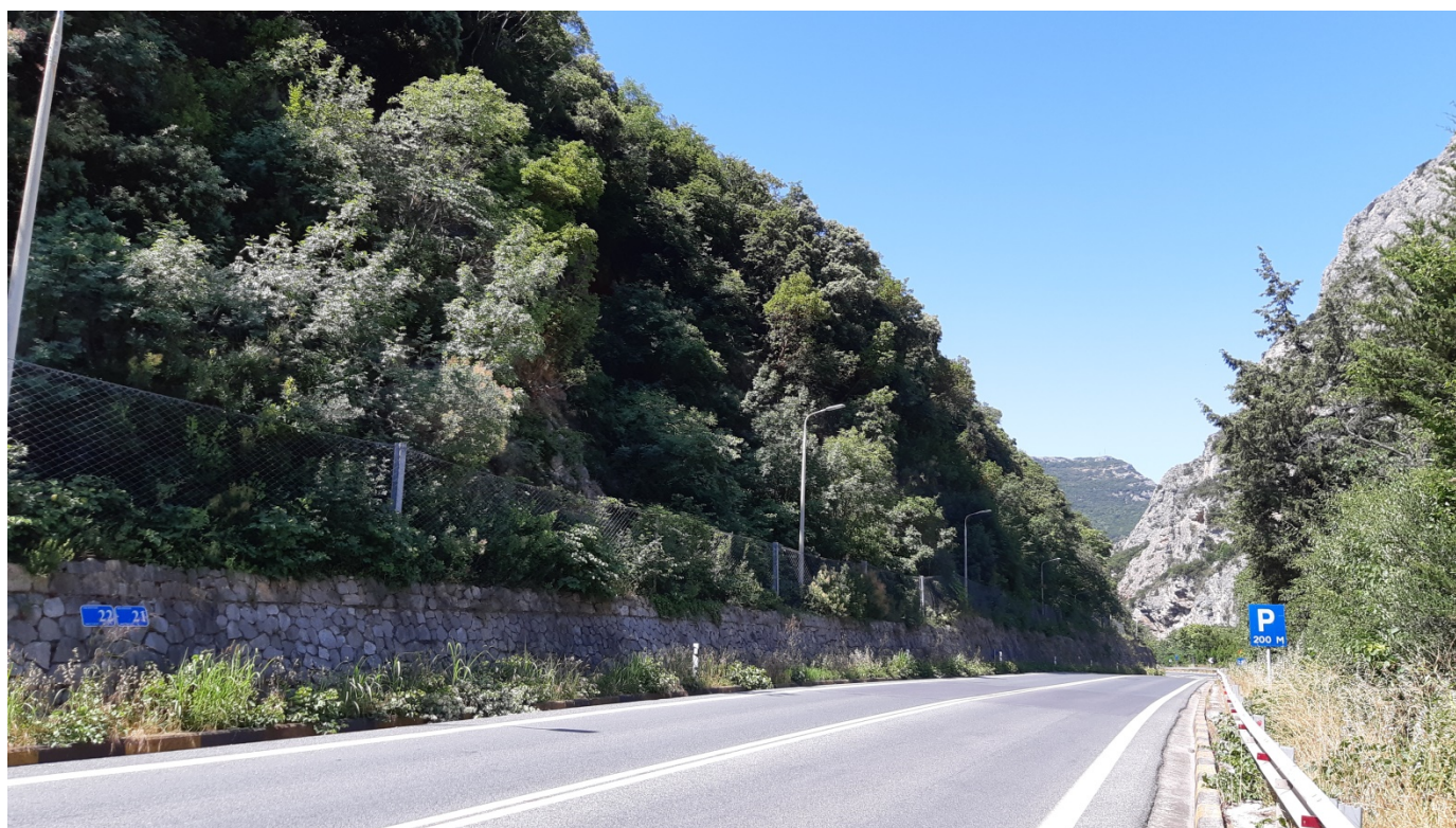
Φωτ. 21.2: Τμήμα 21 – Μετά τις εργασίες προστασίας (Ιούνιος 2020)
