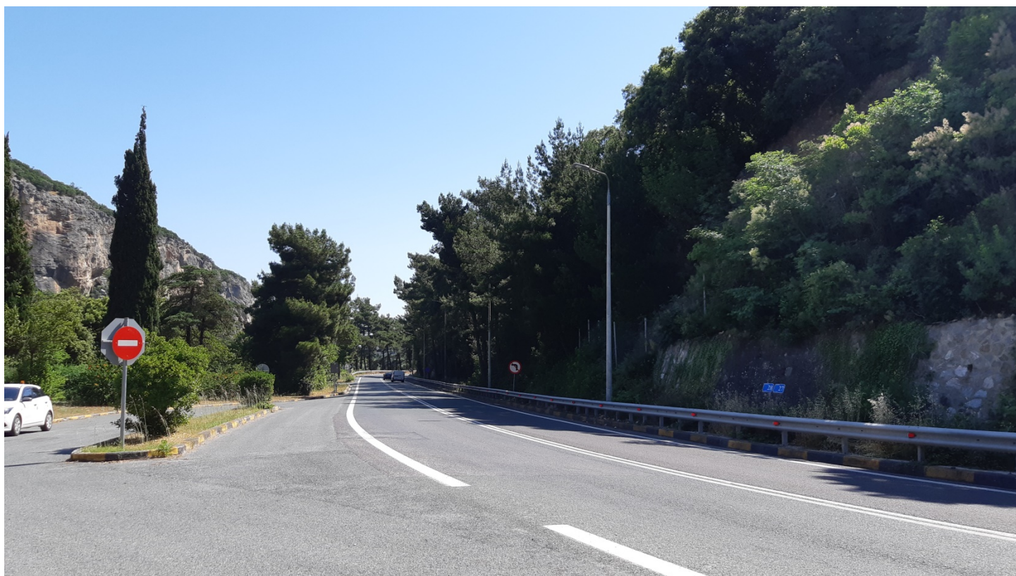
Φωτ. 28.2 : Τμήμα 28 – Μετά τις εργασίες προστασίας (Ιούνιος 2020)
