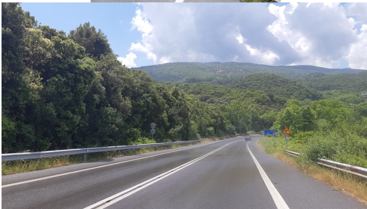
Φωτ. 2.2 : Τμήμα 2 - Μετά τις εργασίες προστασίας (Οκτώβριος 2019)
