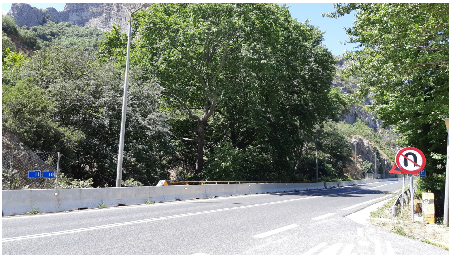
Φωτ. 10.2: Τμήμα 10 – Μετά τις εργασίες προστασίας (Ιούνιος 2020)
