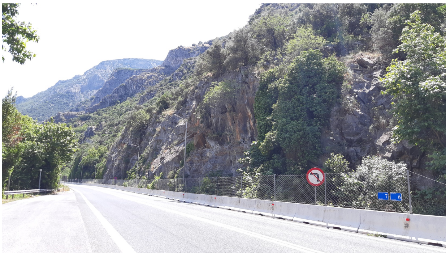
Φωτ. 7.2 : Τμήμα 7 – Μετά τις εργασίες προστασίας (Ιούνιος 2020)
