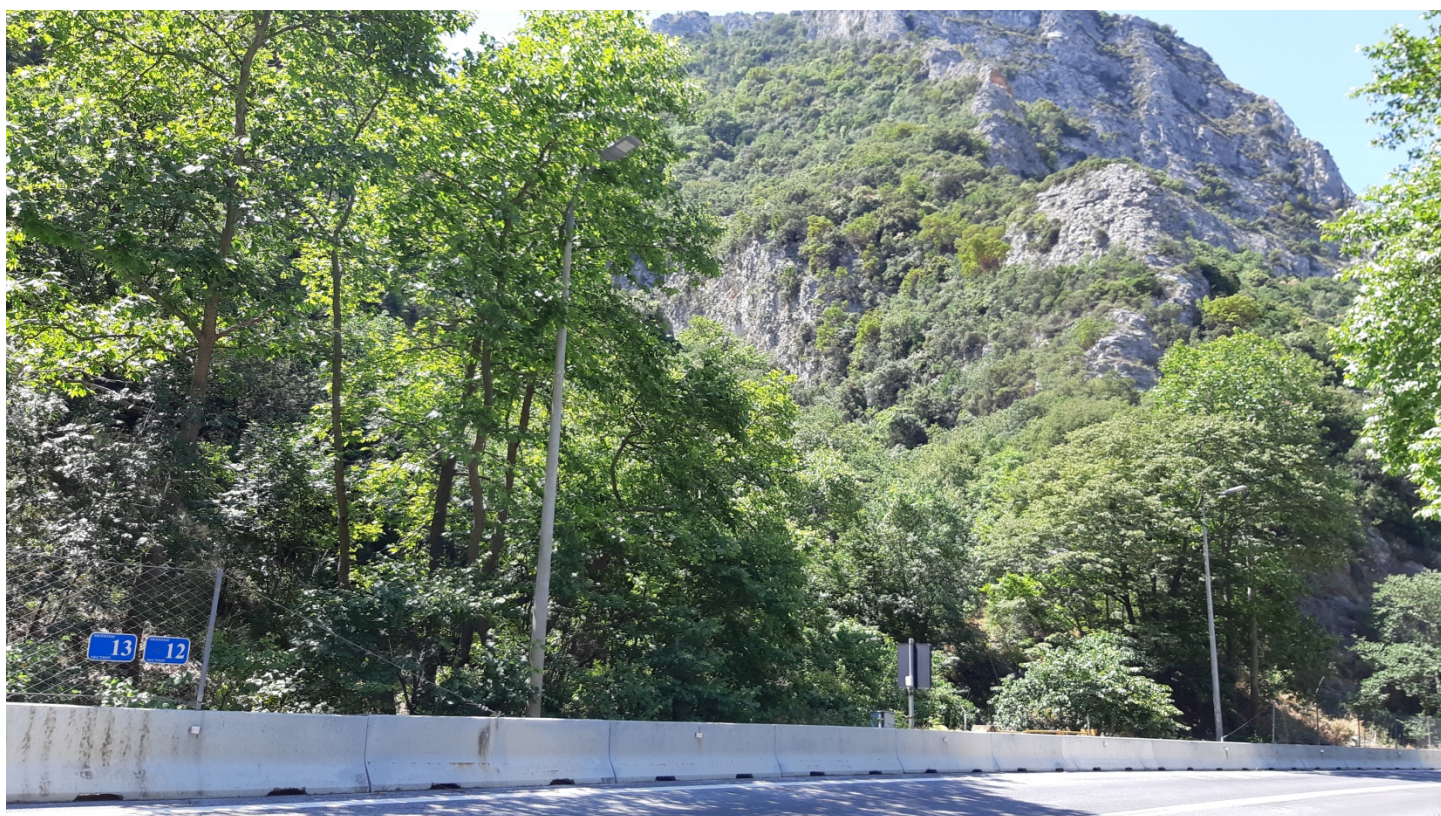
Φωτ. 12.2 : Τμήμα 12 – Μετά τις εργασίες προστασίας (Ιούνιος 2020)
