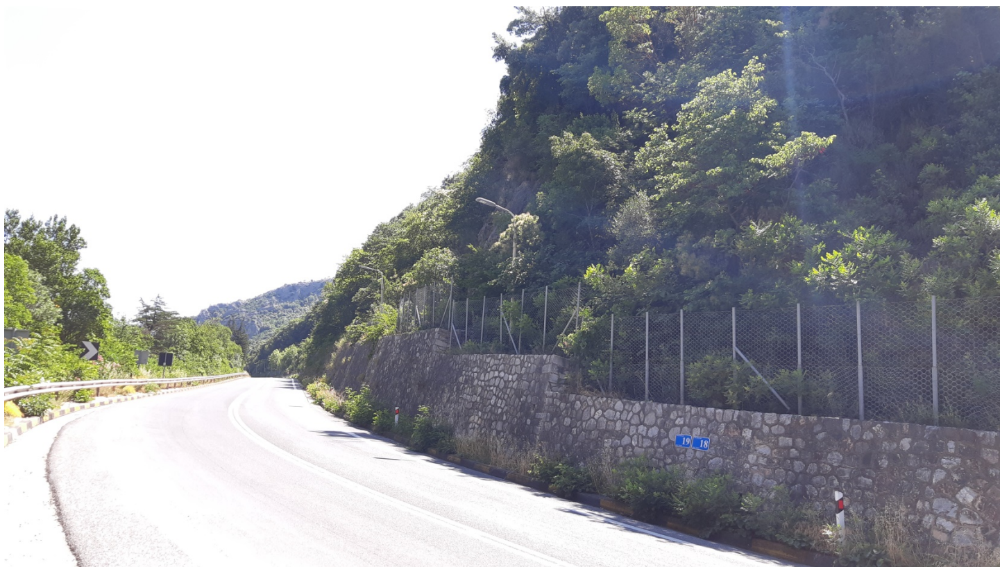
Φωτ. 19.2 : Τμήμα 19 – Μετά τις εργασίες προστασίας (Ιούνιος 2020)
