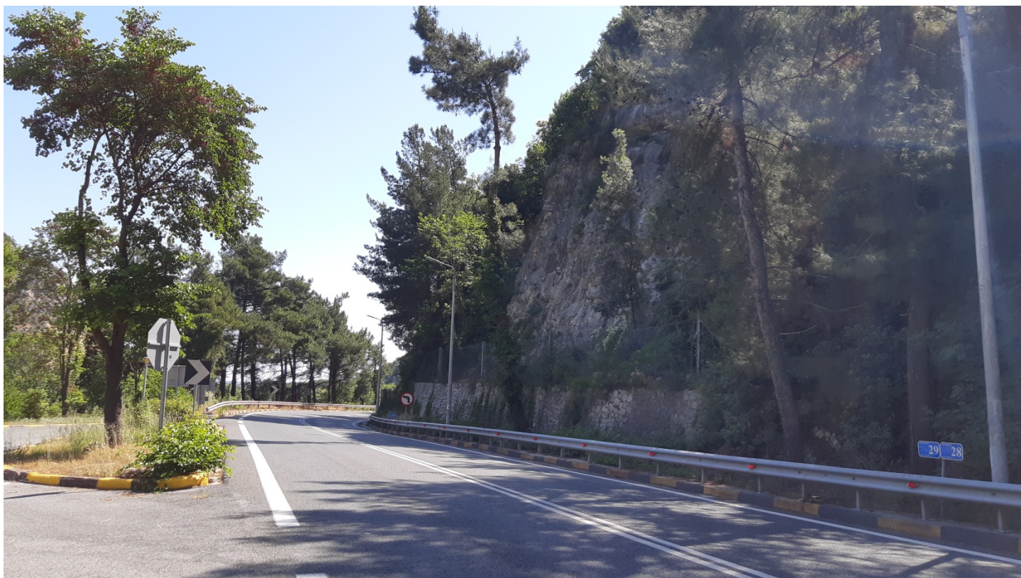
Φωτ. 29.2 : Τμήμα 29 – Μετά τις εργασίες προστασίας (Ιούνιος 2020)
