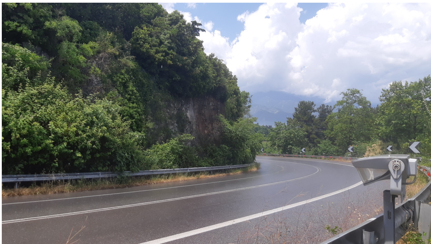
Φωτ. 1.4 : Τμήμα 1 – Μετά τις εργασίες προστασίας (Ιούνιος 2020)
