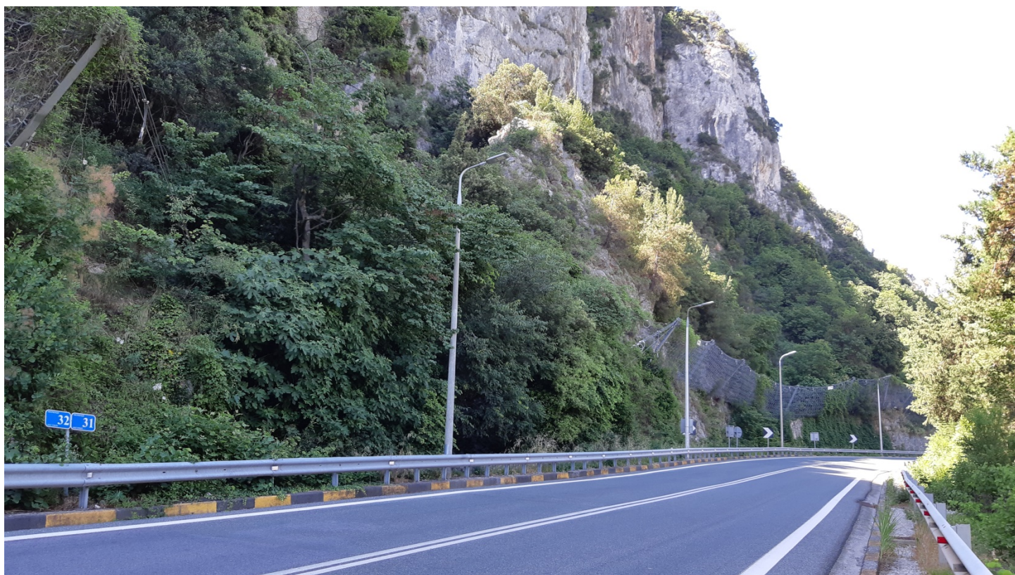
Φωτ. 31.2 : Τμήμα 31 – Μετά τις εργασίες προστασίας (Ιούνιος 2020)
