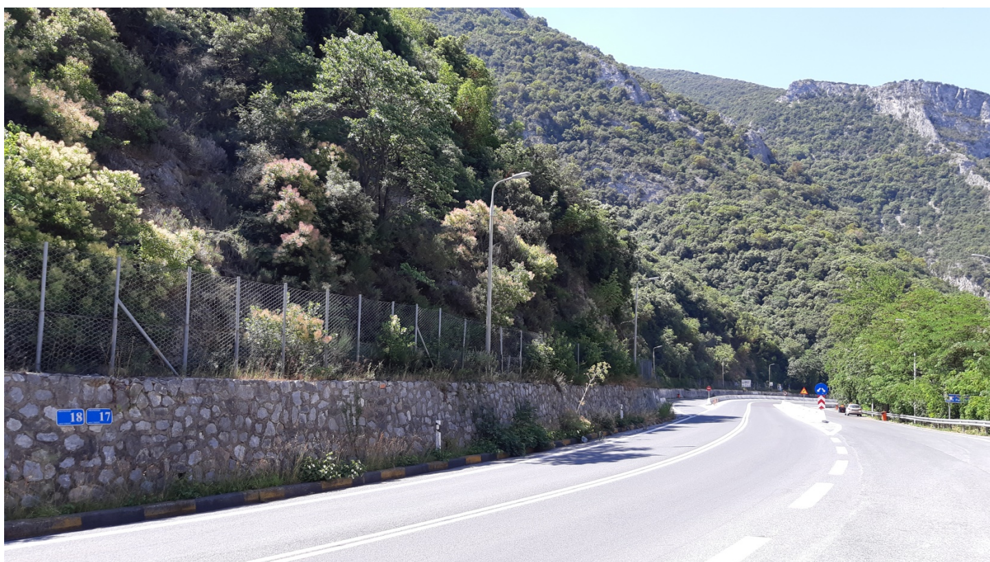
Φωτ. 17.2 : Τμήμα 17 – Μετά τις εργασίες προστασίας (Ιούνιος 2020)
