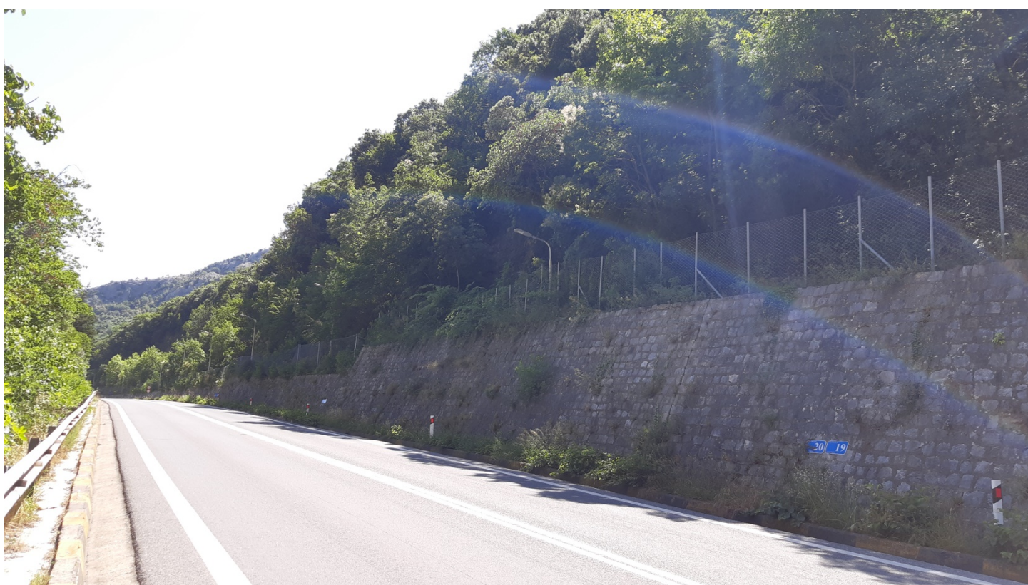
Φωτ. 20.2: Τμήμα 20 – Μετά τις εργασίες προστασίας (Ιούνιος 2020)
