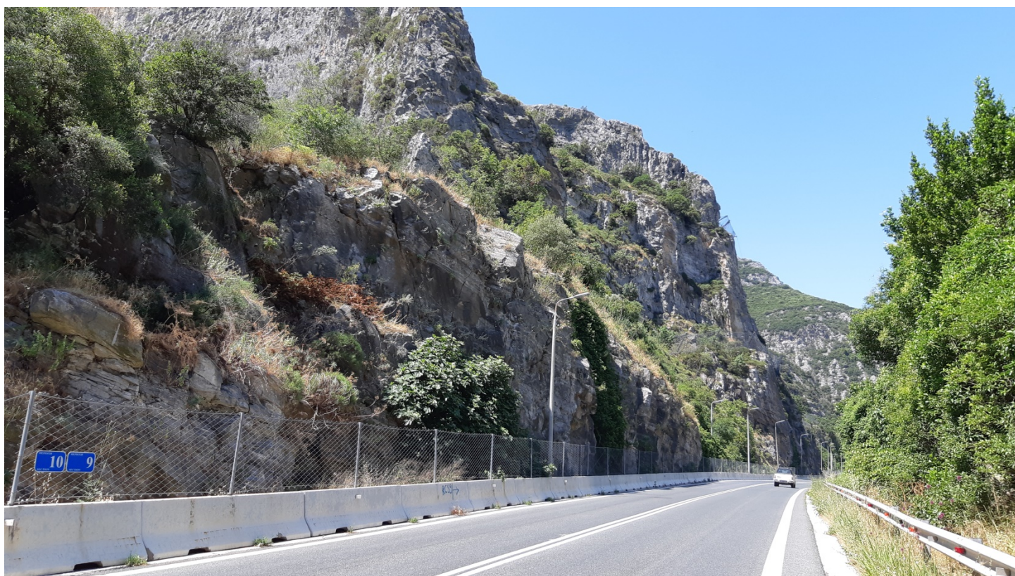
Φωτ. 9.2: Τμήμα 9 – Μετά τις εργασίες προστασίας (Ιούνιος 2020)
