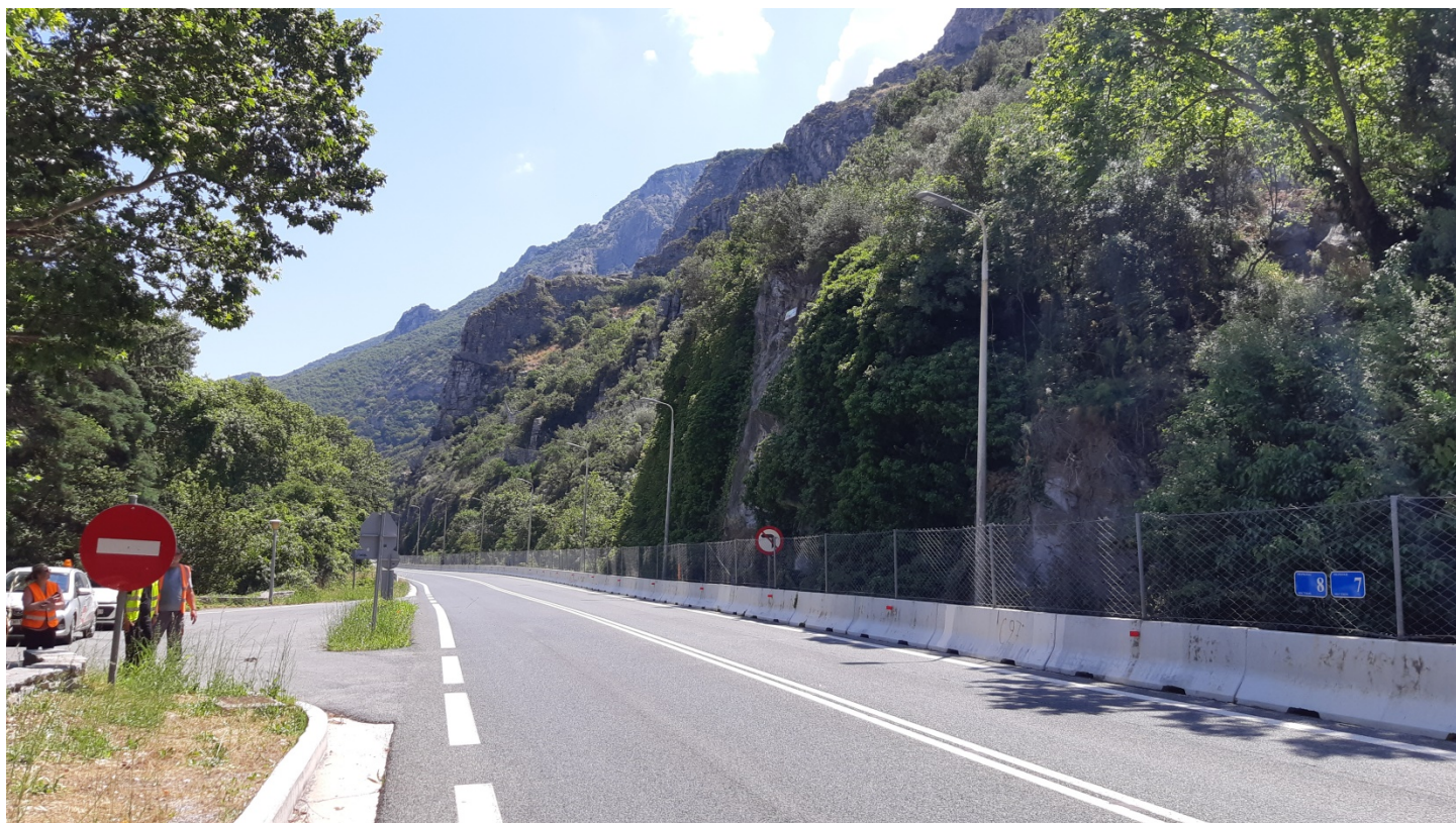
Φωτ. 8.2 : Τμήμα 8 – Μετά τις εργασίες προστασίας (Ιούνιος 2020)
