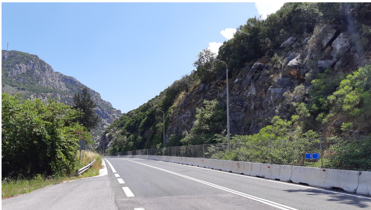
Φωτ. 3.2 : Τμήμα 3 – Μετά τις εργασίες προστασίας (Ιούνιος 2020)
