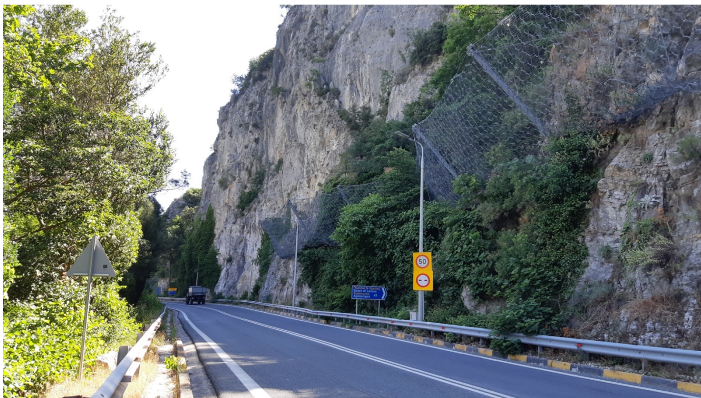
Φωτ. 33.2 : Τμήμα 33 - Μετά τις εργασίες προστασίας (Ιούνιος 2020).
