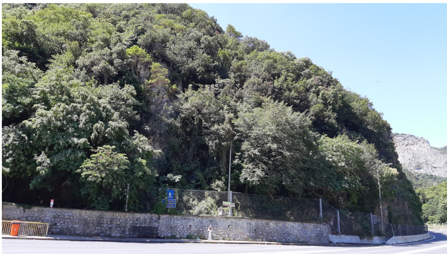
Φωτ. 15.2 : Τμήμα 15 – Μετά τις εργασίες προστασίας (Ιούνιος 2020)
