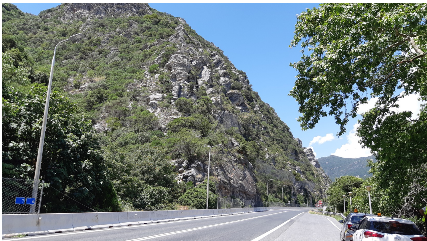
Φωτ. 6.2 : Τμήμα 6 – Μετά τις εργασίες προστασίας (Ιούνιος 2020)
