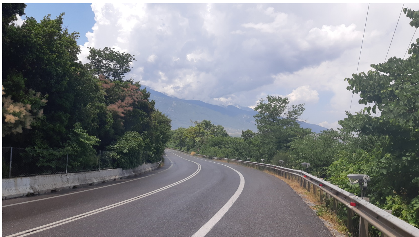
Φωτ. 6.2: Τμήμα 6 – Μετά τις εργασίες προστασίας (Ιούνιος 2020)
