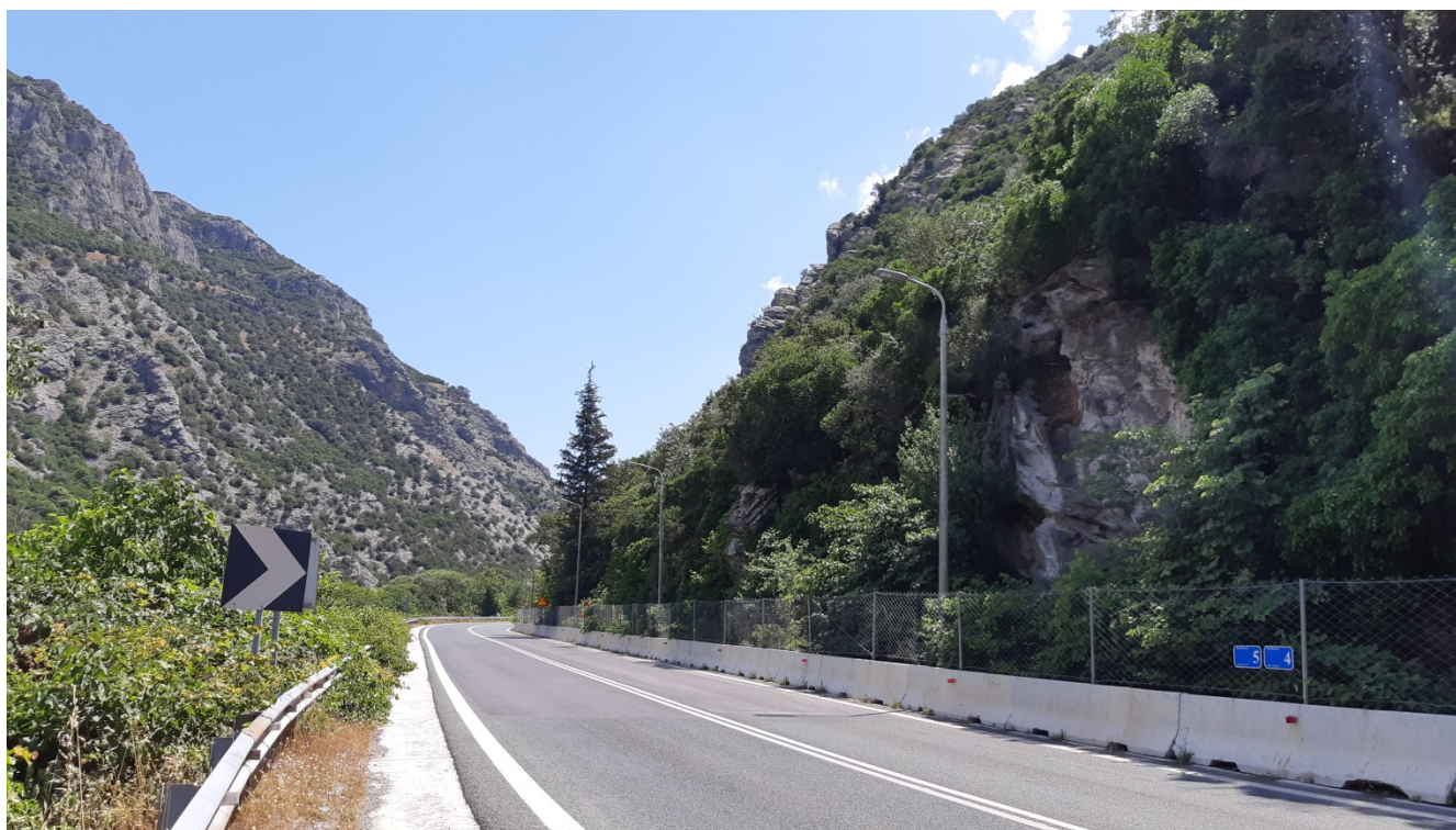
Φωτ. 5.2 : Τμήμα 5 – Μετά τις εργασίες προστασίας (Ιούνιος 2020)
