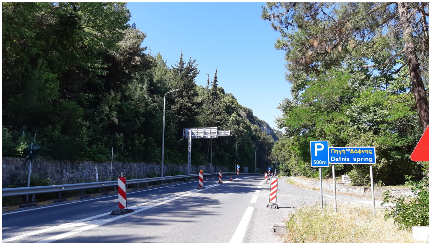
Φωτ. 34.1 : Τμήμα 34 - Πριν και μετά τις εργασίες προστασίας.
