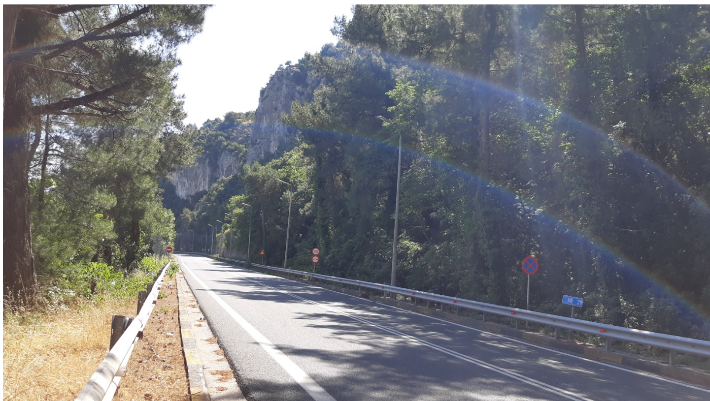
Φωτ. 30.2 : Τμήμα 30 – Μετά τις εργασίες προστασίας (Ιούνιος 2020)
