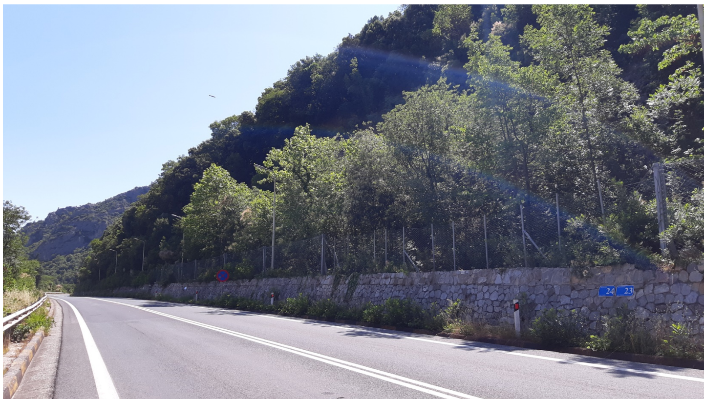
Φωτ. 24.2 : Τμήμα 24 – Μετά τις εργασίες προστασίας (Ιούνιος 2020)
