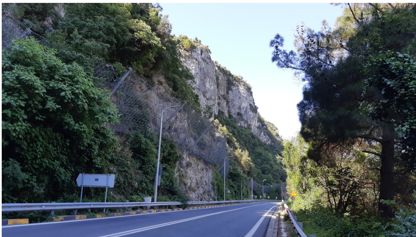
Φωτ. 32.2 : Τμήμα 32 – Μετά τις εργασίες προστασίας (Ιούνιος 2020).
