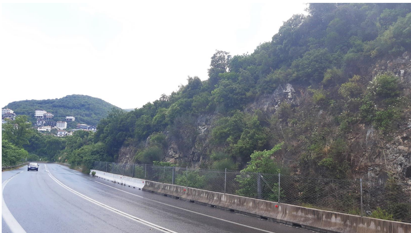
Φωτ. 4.2 : Τμήμα 4 – Μετά τις εργασίες προστασίας (Ιούνιος 2020)
