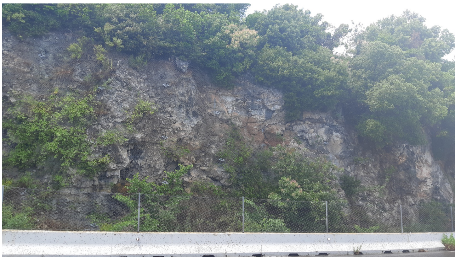
Φωτ. 5.2 : Τμήμα 5 - Μετά τις εργασίες προστασίας (Ιούνιος 2020)
