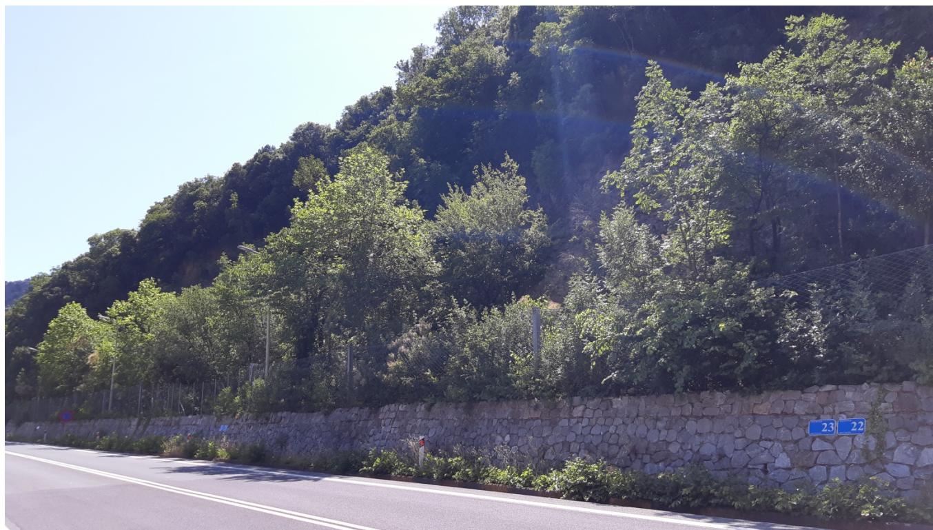
Φωτ. 23.3 : Τμήμα 23 – Μετά τις εργασίες προστασίας (Ιούνιος 2020)
