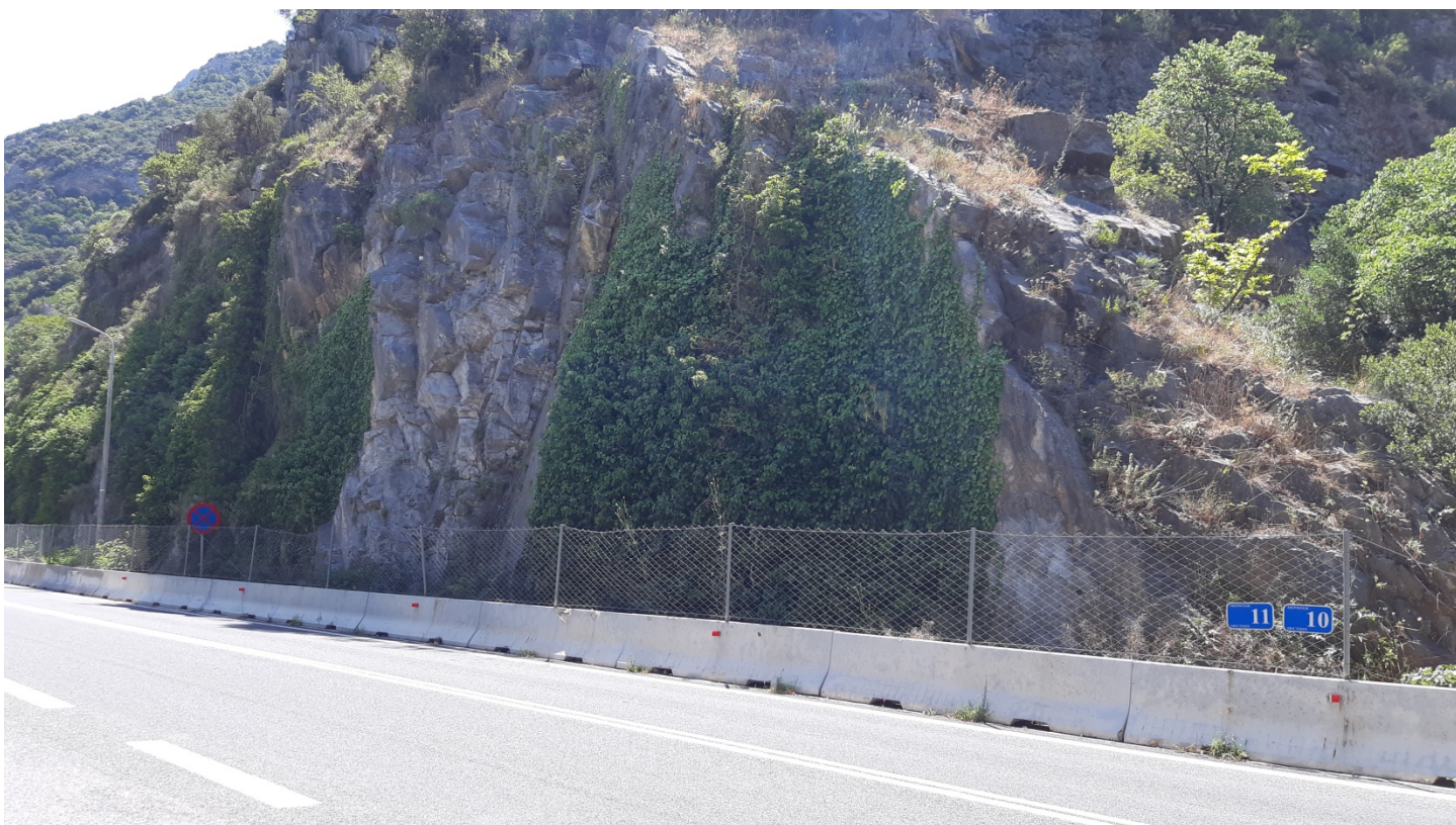
Φωτ. 11.2: Τμήμα 11 – Μετά τις εργασίες προστασίας (Ιούνιος 2020)
