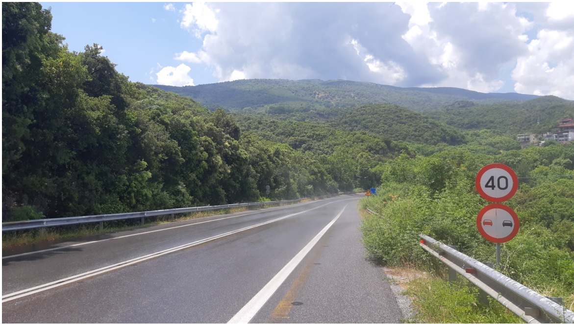
Φωτ. 2.4 : Τμήμα 2 – Μετά τις εργασίες προστασίας (Ιούνιος 2020)
