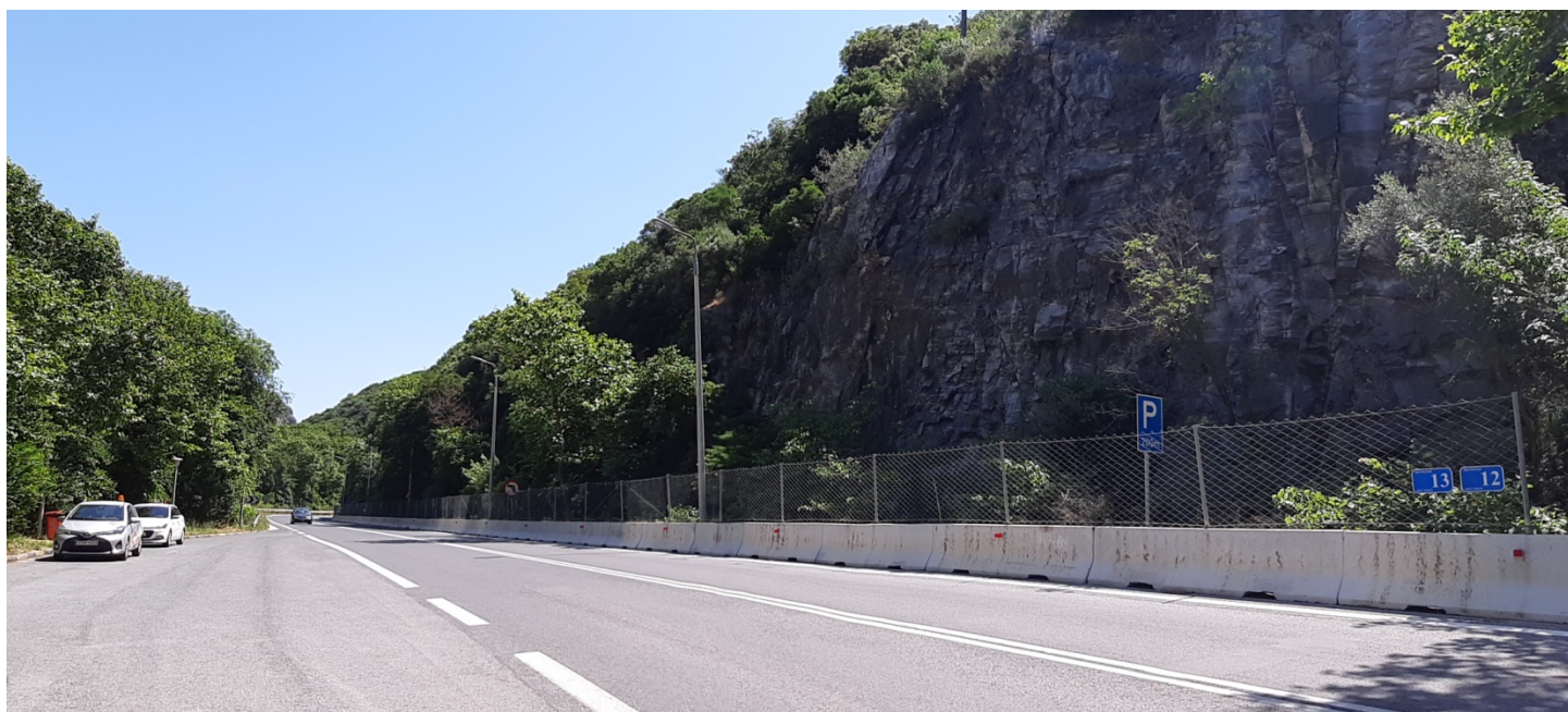
Φωτ. 13.2 : Τμήμα 13 – Μετά τις εργασίες προστασίας (Ιούνιος 2020)
