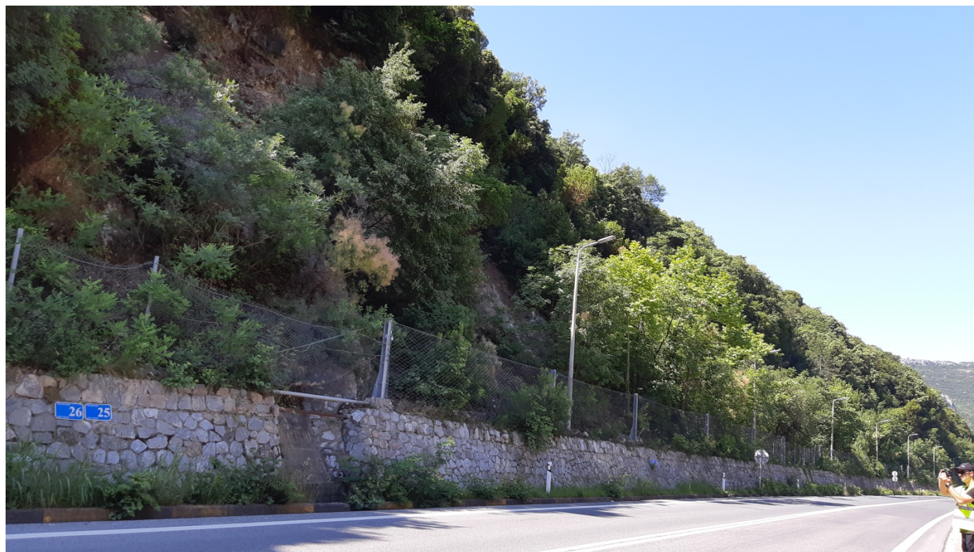
Φωτ. 25.2 : Τμήμα 25 – Μετά τις εργασίες προστασίας (Ιούνιος 2020)
