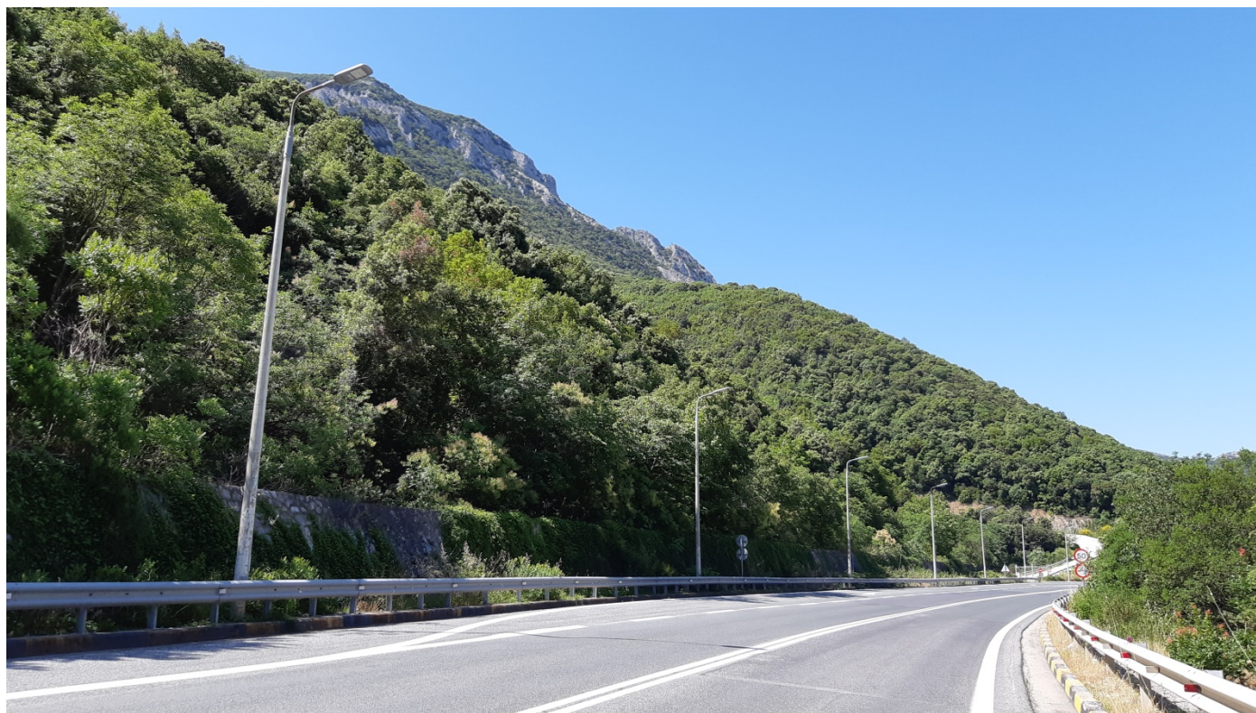
Φωτ. 26.2 : Τμήμα 26 – Μετά τις εργασίες προστασίας (Ιούνιος 2020)
