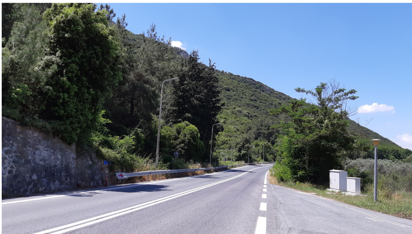
Φωτ. 1.2: Τμήμα 1 – Μετά τις εργασίες προστασίας (Ιούνιος 2020)
