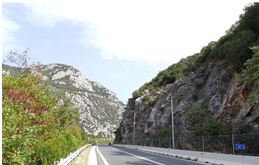
Φωτ. 4.2: Τμήμα 4 – Μετά τις εργασίες προστασίας (Οκτώβριος 2019)
