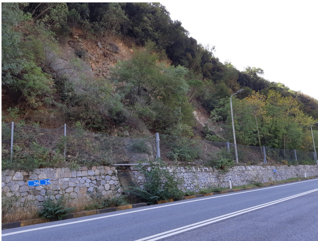
Φωτ. 25.2 : Τμήμα 25 – Μετά τις εργασίες προστασίας (Οκτώβριος 2019)
