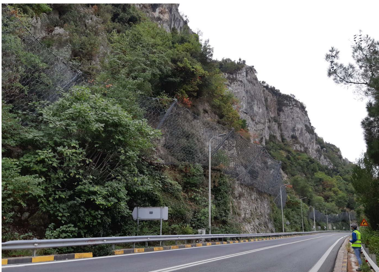
Φωτ. 32.2 : Τμήμα 32 – Μετά τις εργασίες προστασίας (Οκτώβριος 2019)
