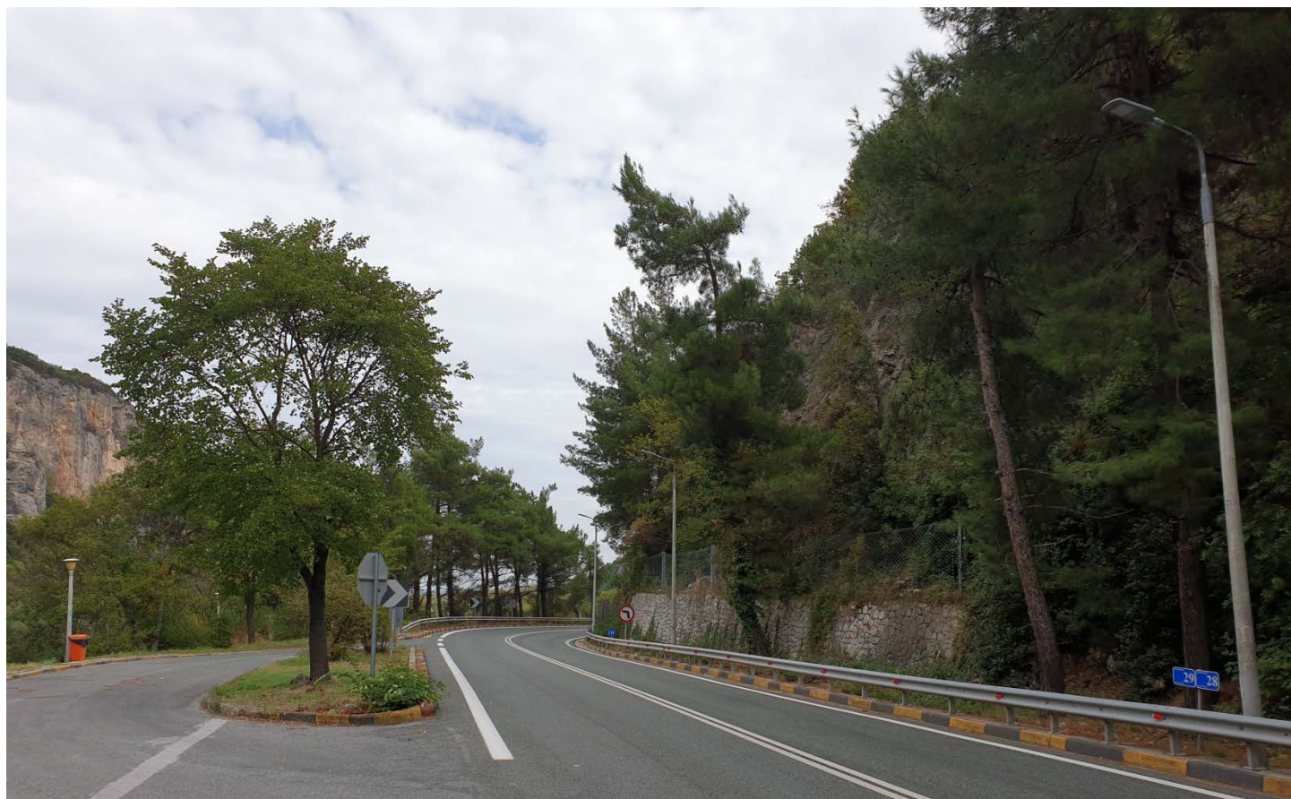
Φωτ. 29.2 : Τμήμα 29 – Μετά τις εργασίες προστασίας (Οκτώβριος 2019)
