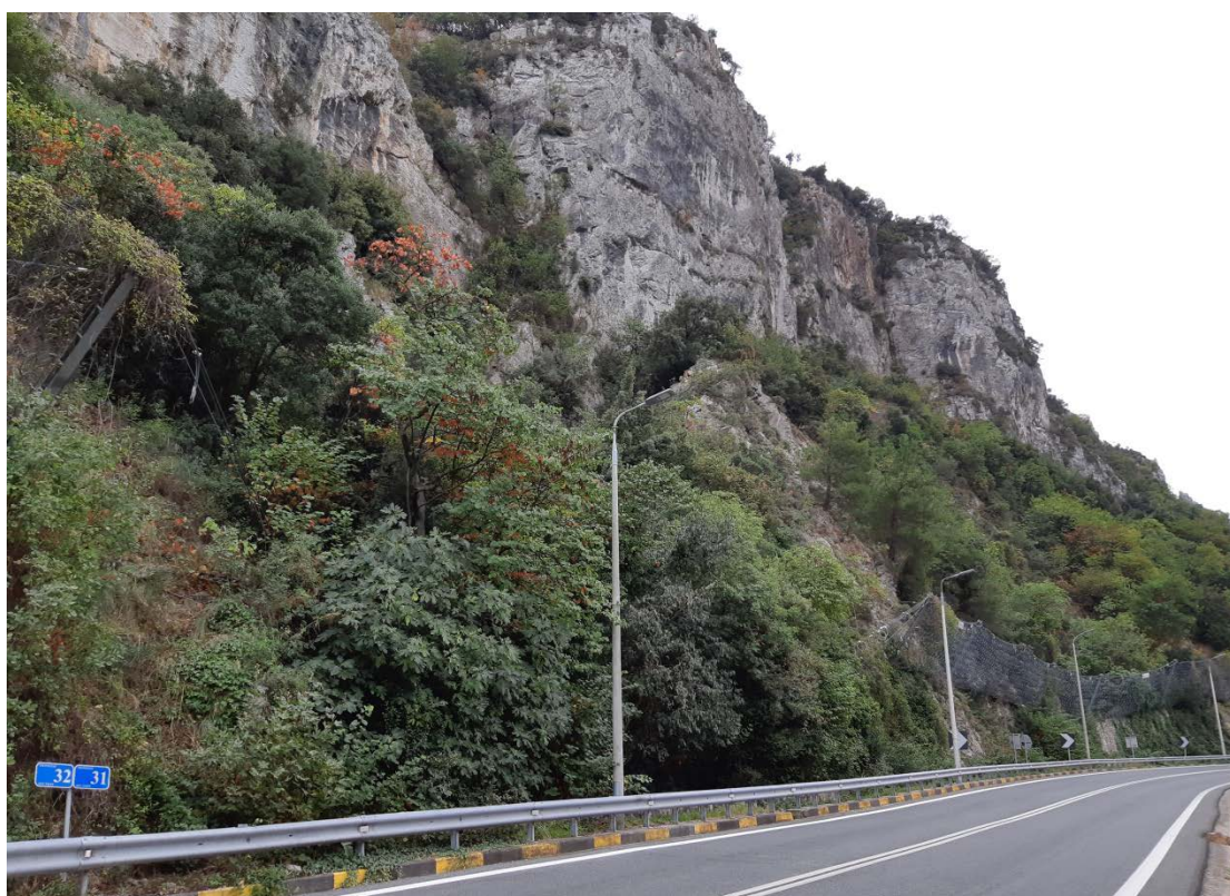
Φωτ. 31.2 : Τμήμα 31 – Μετά τις εργασίες προστασίας (Οκτώβριος 2019)
