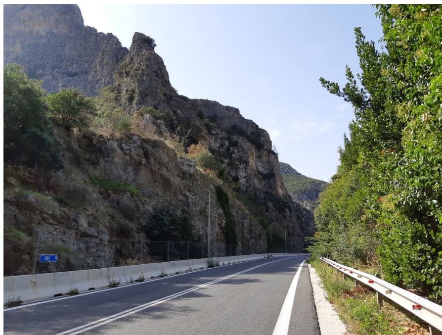
Φωτ. 9.2: Τμήμα 9 – Μετά τις εργασίες προστασίας (Οκτώβριος 2019)
