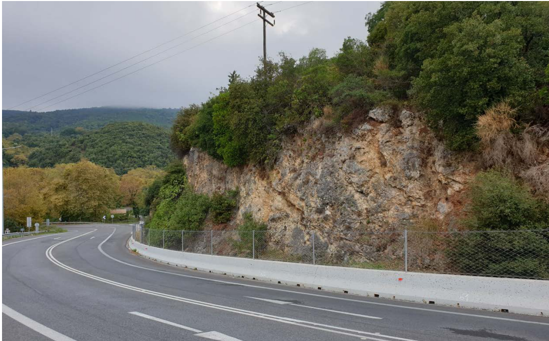
Φωτ. 3.3 : Τμήμα 3 – Μετά τις εργασίες προστασίας (Οκτώβριος 2019)
