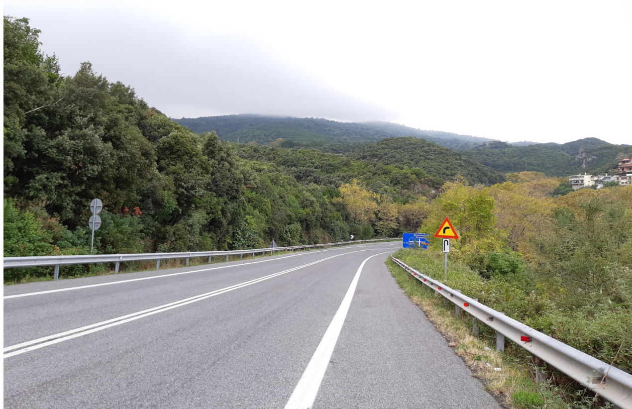
Φωτ. 2.2 : Τμήμα 2 - Μετά τις εργασίες προστασίας (Οκτώβριος 2019)
