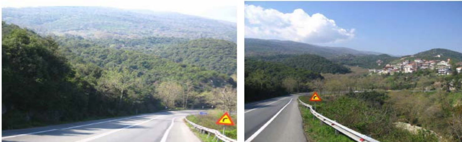
Φωτ. 2.1 : Τμήμα 2 - Πριν τις εργασίες προστασίας (Νοέμβριος 2009)
