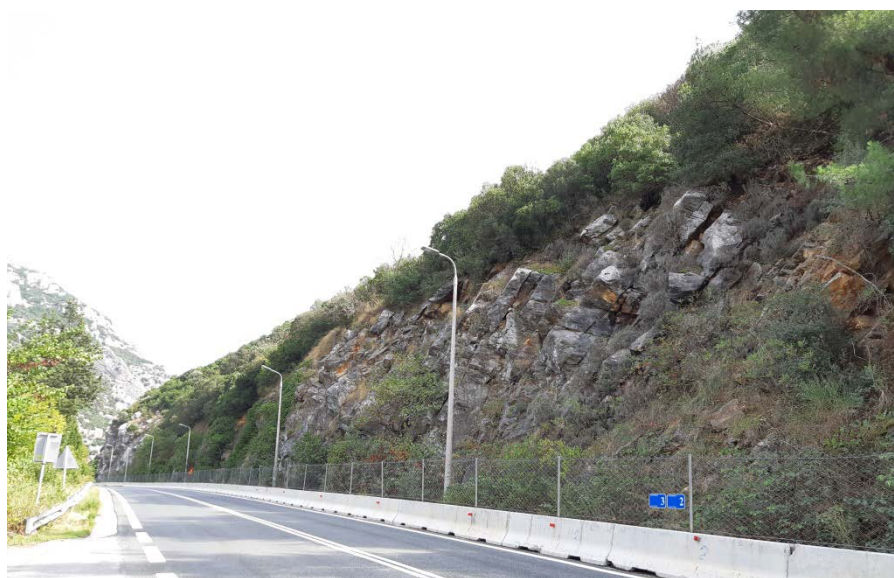
Φωτ. 3.2 : Τμήμα 3 – Μετά τις εργασίες προστασίας (Οκτώβριος 2019)
