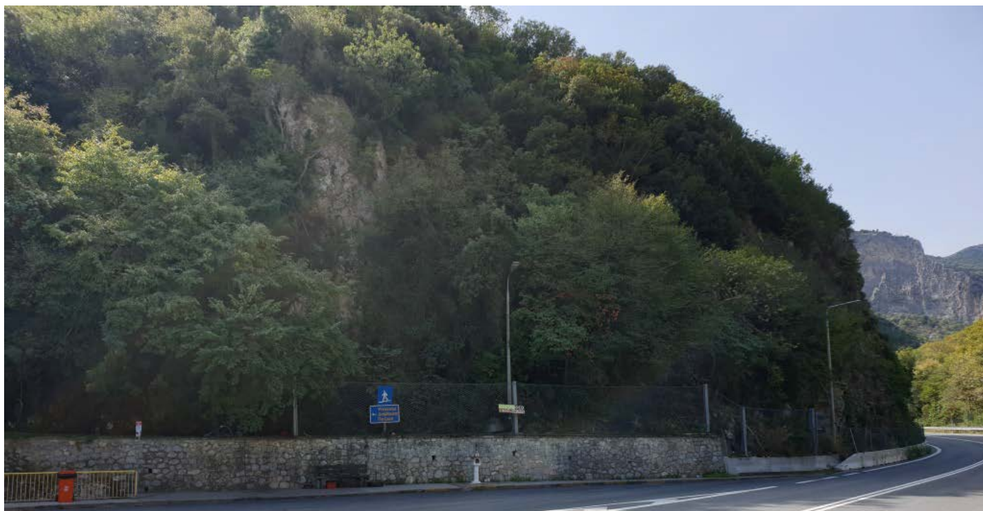
Φωτ. 15.2 : Τμήμα 15 – Μετά τις εργασίες προστασίας (Οκτώβριος 2019)
