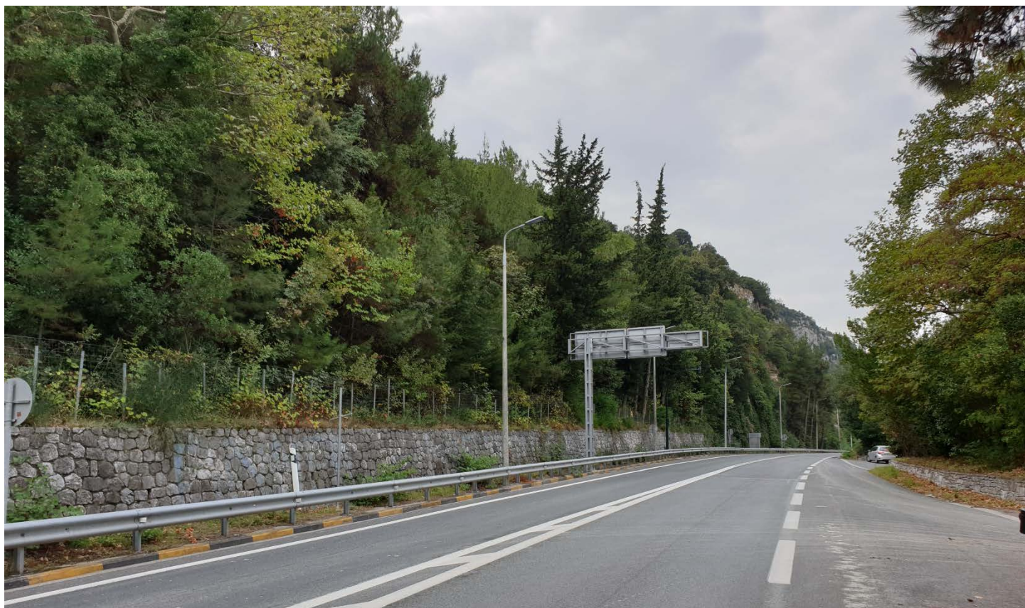
Φωτ. 34.2 : Τμήμα 34 – Μετά τις εργασίες προστασίας (Οκτώβριος 2019)
