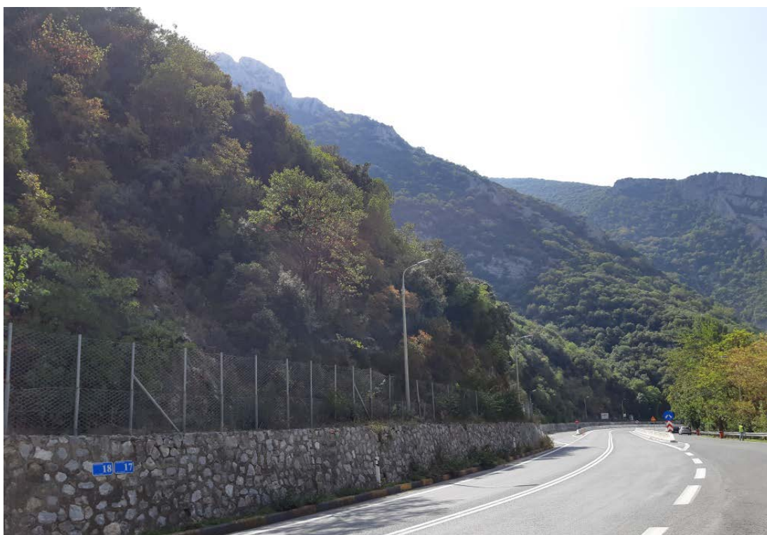
Φωτ. 17.2 : Τμήμα 17 – Μετά τις εργασίες προστασίας (Οκτώβριος 2019)
