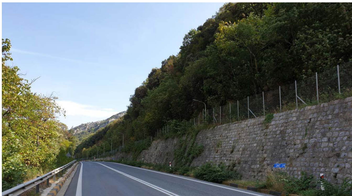
Φωτ. 20.2: Τμήμα 20 – Μετά τις εργασίες προστασίας (Οκτώβριος 2019)
