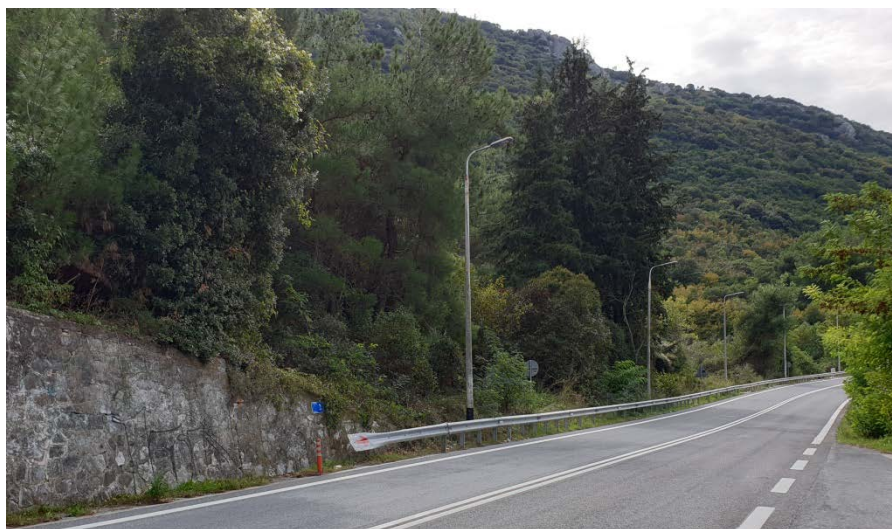
Φωτ. 1.2: Τμήμα 1 – Μετά τις εργασίες προστασίας (Οκτώβριος 2019)
