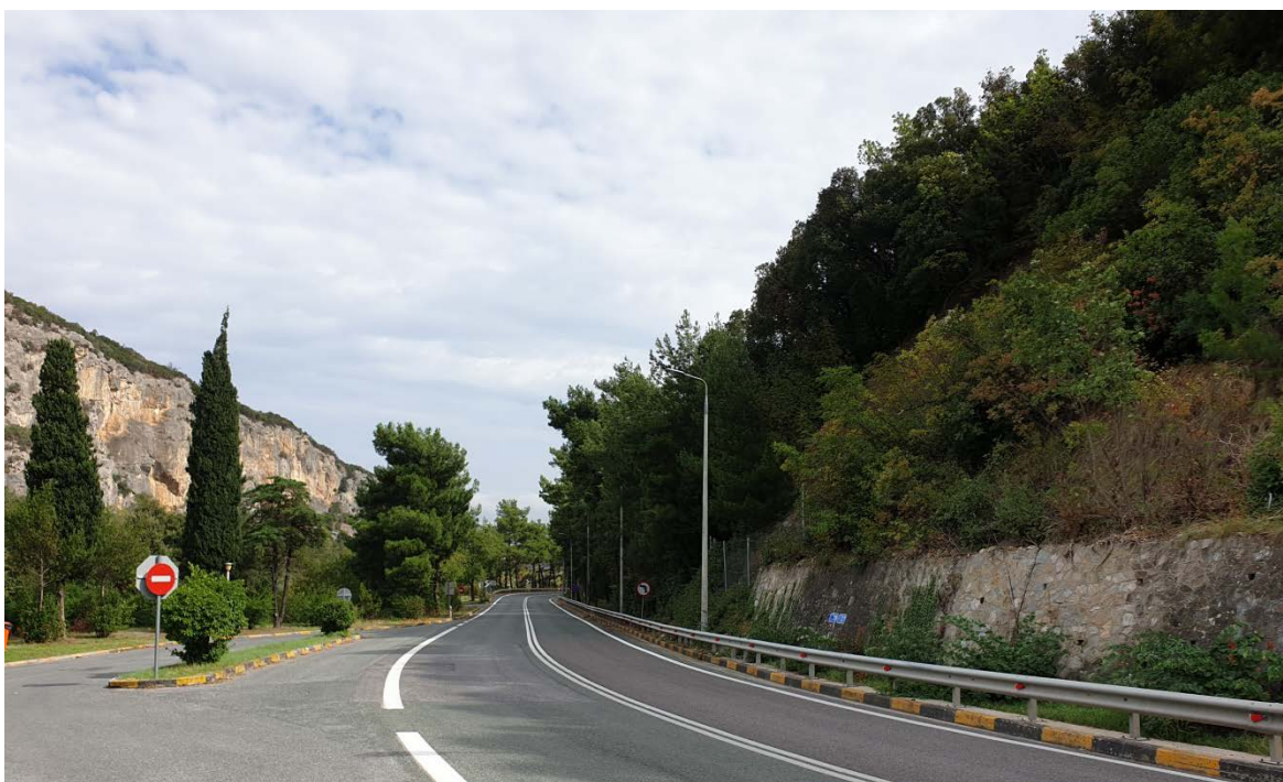
Φωτ. 28.2 : Τμήμα 28 – Μετά τις εργασίες προστασίας (Οκτώβριος 2019)
