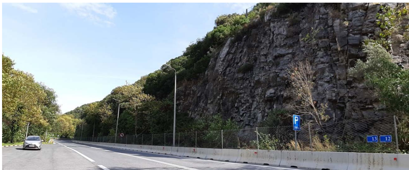
Φωτ. 13.2 : Τμήμα 13 – Μετά τις εργασίες προστασίας (Οκτώβριος 2019)
