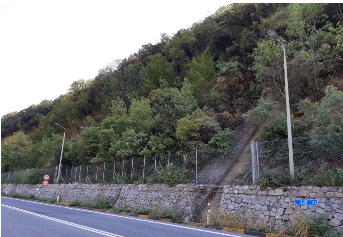
Φωτ. 22.2 : Τμήμα 22 – Μετά τις εργασίες προστασίας (Οκτώβριος 2019)
