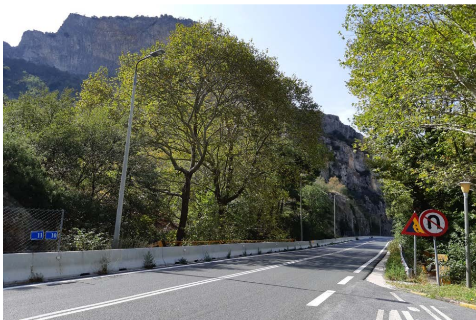
Φωτ. 10.2: Τμήμα 10 – Μετά τις εργασίες προστασίας (Οκτώβριος 2019)
