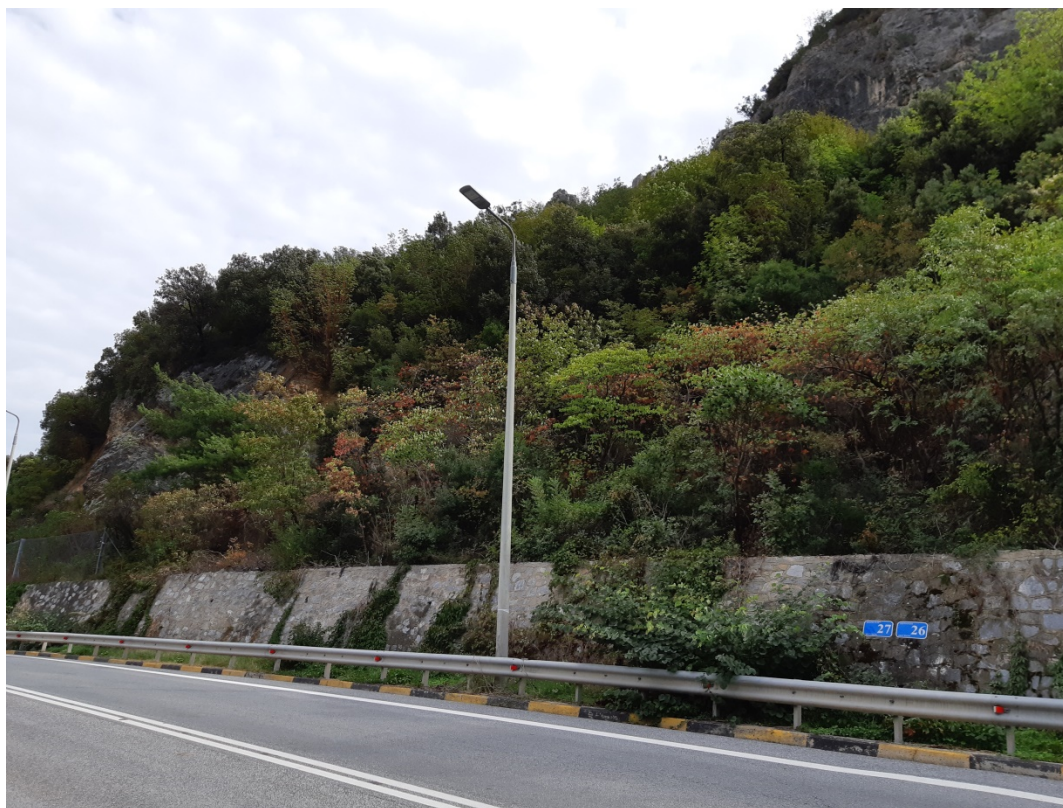
Φωτ. 27.2 : Τμήμα 27 – Μετά τις εργασίες προστασίας (Οκτώβριος 2019)
