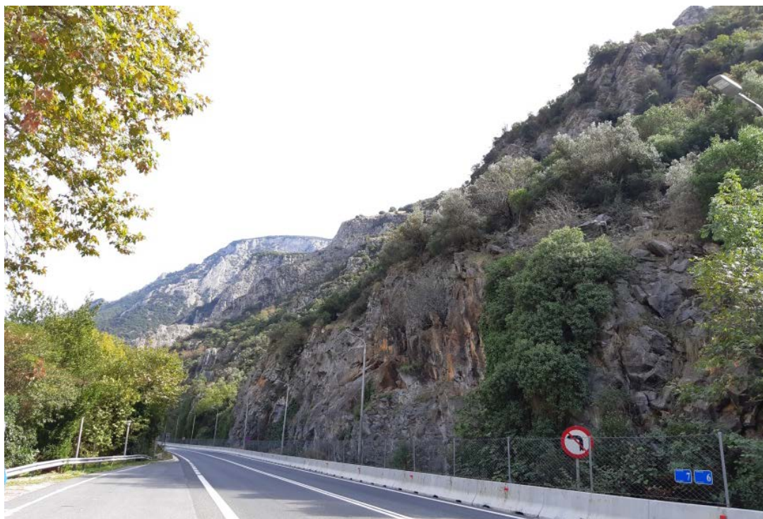
Φωτ. 7.2 : Τμήμα 7 – Μετά τις εργασίες προστασίας (Οκτώβριος 2019)
