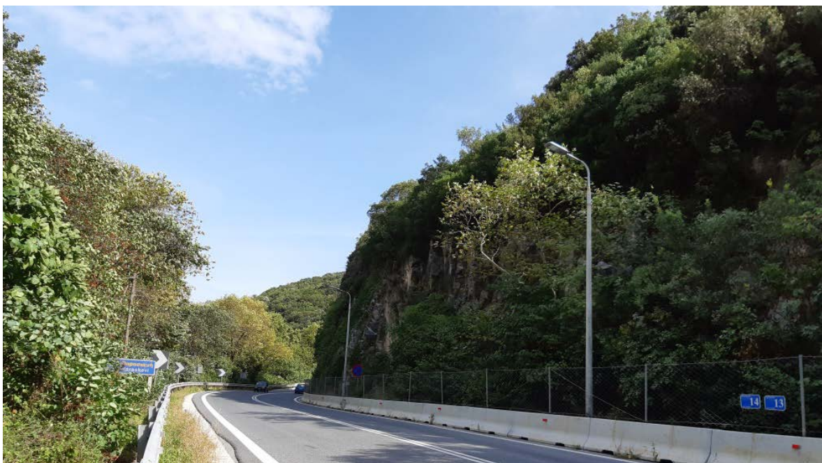
Φωτ. 14.2 : Τμήμα 14 – Μετά τις εργασίες προστασίας (Οκτώβριος 2019)
