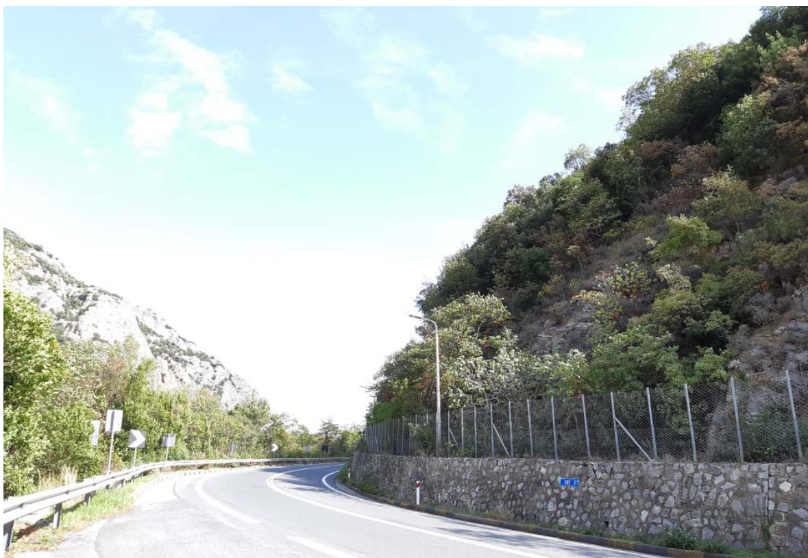
Φωτ. 18.2 : Τμήμα 18 – Μετά τις εργασίες προστασίας (Οκτώβριος 2019)
