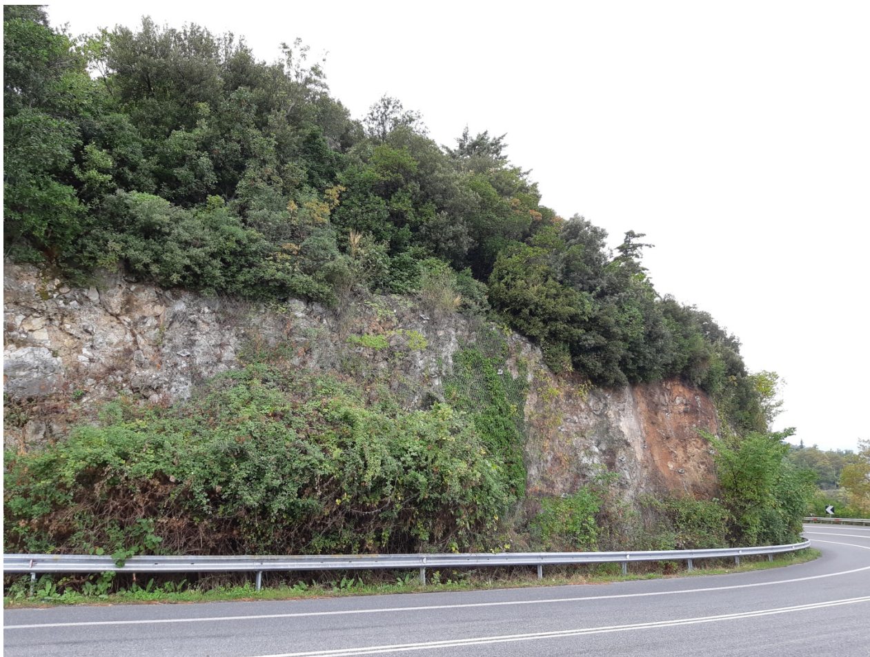
Φωτ. 1.4 : Τμήμα 1 – Μετά τις εργασίες προστασίας (Οκτώβριος 2019)
