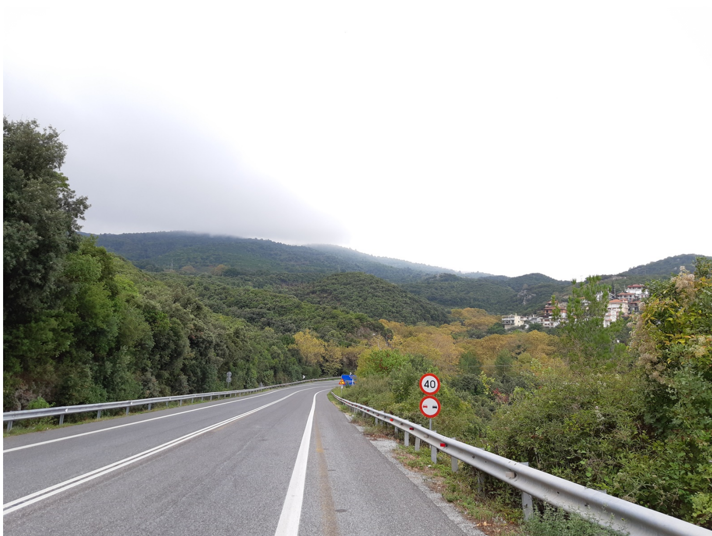
Φωτ. 2.4 : Τμήμα 2 – Μετά τις εργασίες προστασίας (Οκτώβριος 2018)
