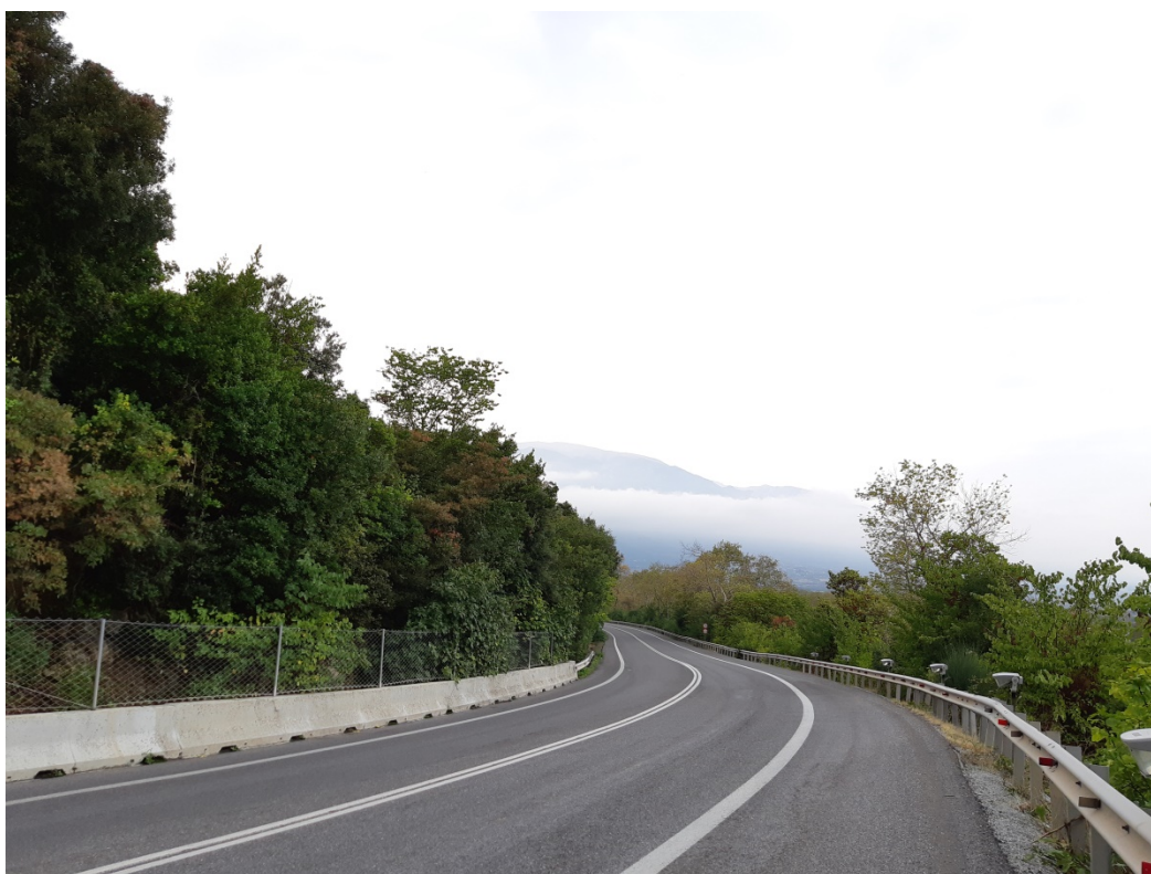
Φωτ. 6.2: Τμήμα 6 – Μετά τις εργασίες προστασίας (Οκτώβριος 2019)
