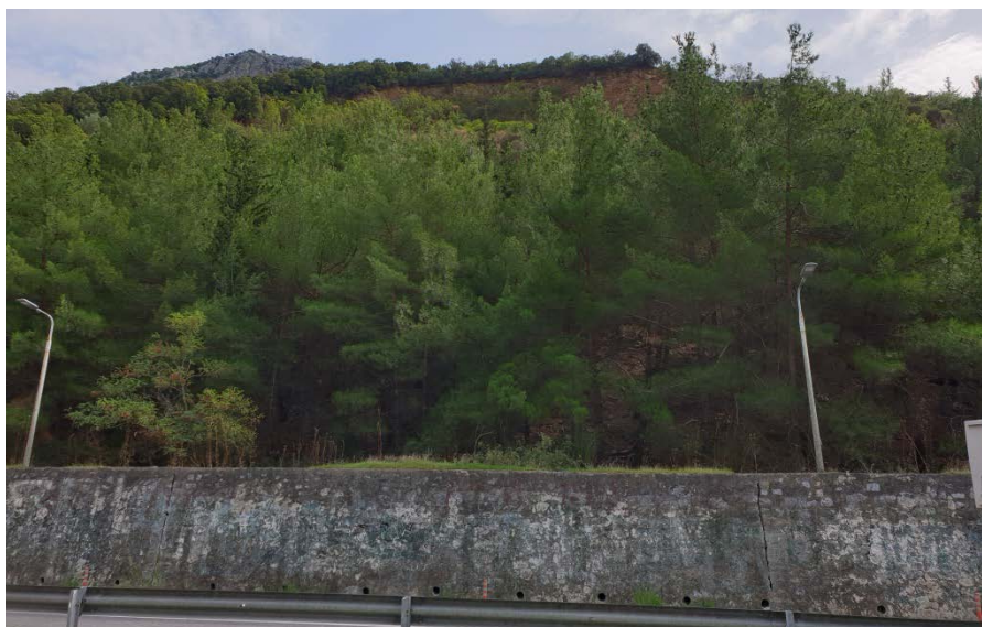
Φωτ. 2.3: Τμήμα 2 – Μετά τις εργασίες προστασίας (Οκτώβριος 2019)
