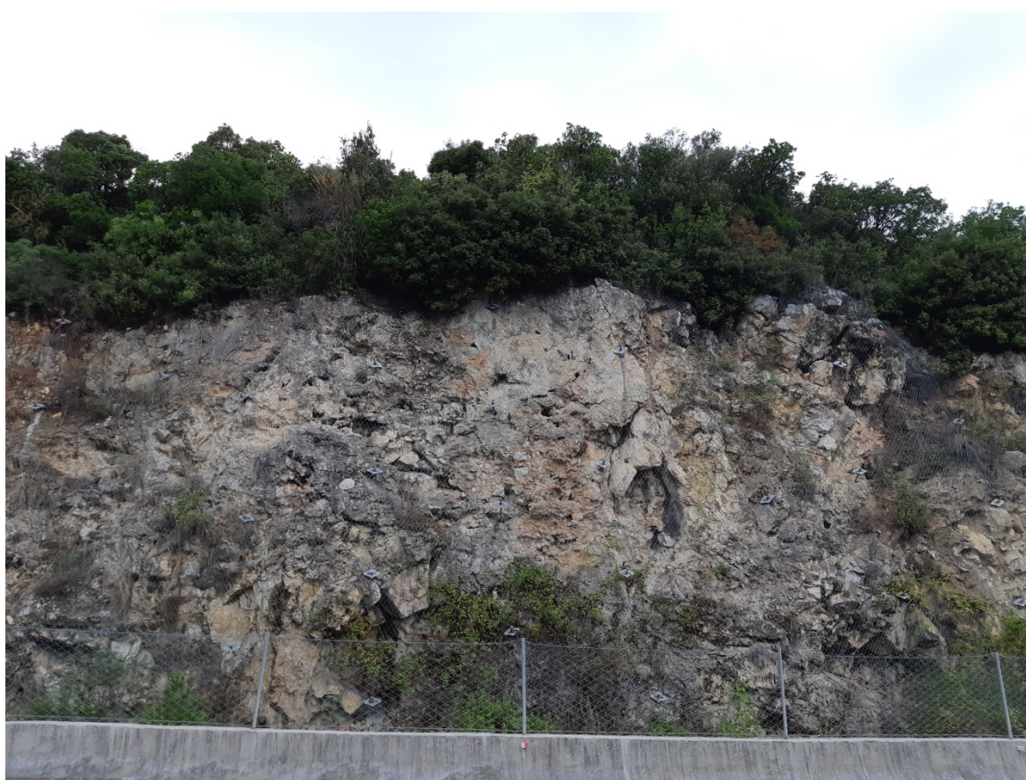
Φωτ. 5.2 : Τμήμα 5 - Μετά τις εργασίες προστασίας (Οκτώβριος 2019)
