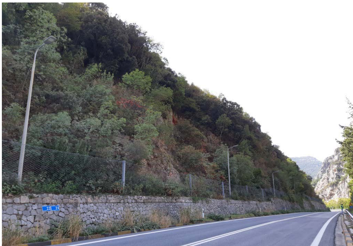
Φωτ. 21.2: Τμήμα 21 – Μετά τις εργασίες προστασίας (Οκτώβριος 2019)
