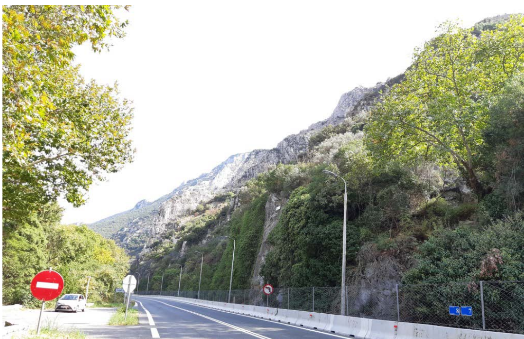
Φωτ. 8.2 : Τμήμα 8 – Μετά τις εργασίες προστασίας (Οκτώβριος 2019)
