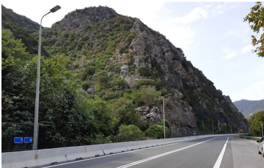
Φωτ. 6.2 : Τμήμα 6 – Μετά τις εργασίες προστασίας (Οκτώβριος 2019)
