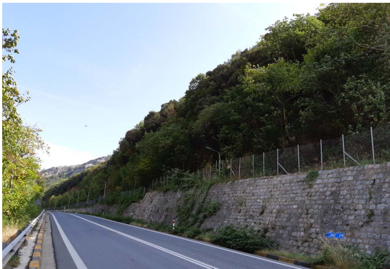
Φωτ. 19.2 : Τμήμα 19 – Μετά τις εργασίες προστασίας (Οκτώβριος 2019)
