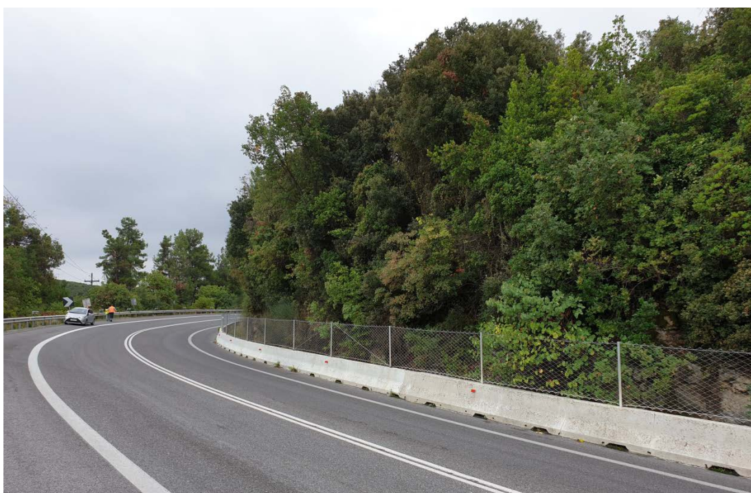
Φωτ. 5.4 : Τμήμα 5 – Μετά τις εργασίες προστασίας (Οκτώβριος 2019)
