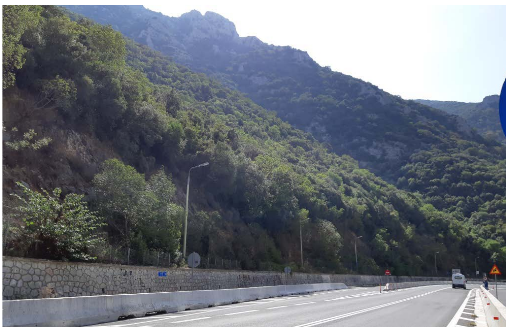
Φωτ. 16.2 : Τμήμα 16 – Μετά τις εργασίες προστασίας (Οκτώβριος 2019)
