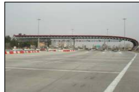
Σταθμός διοδίων Λεπτοκαρυάς
